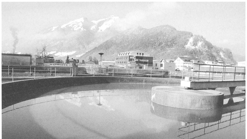
5.3. Die ARA-Rotzwinkel muss saniert werden.
