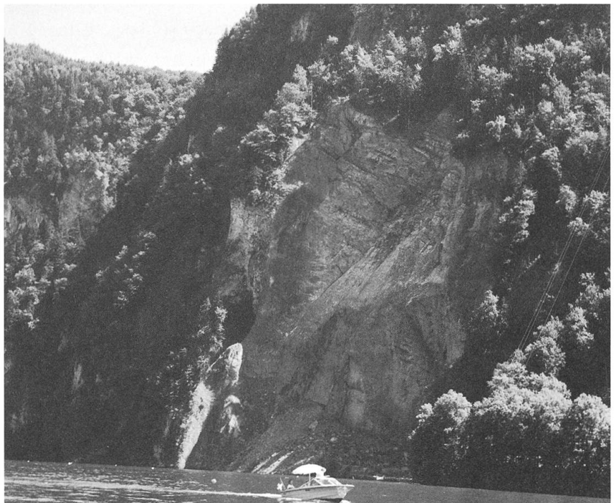
3.8. Felsstürze haben bei der Obermatt am Ufer Schutt hinterlassen.
