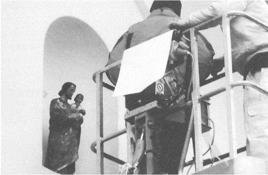
19.3. Mit Hebebühne wurde die Josefstatue in die Nische gebracht.
