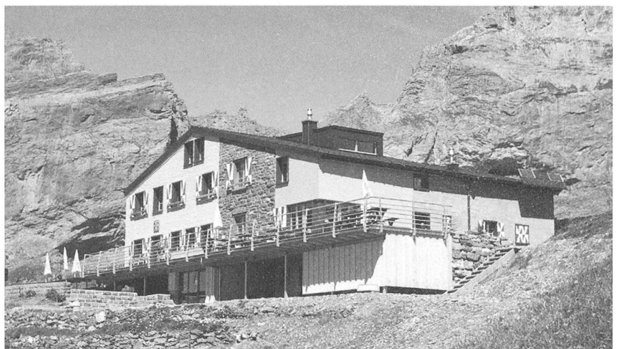
3.7. Die sanierte und umgebaute Rugghubelhütte der Sektion Titlis SAC.
