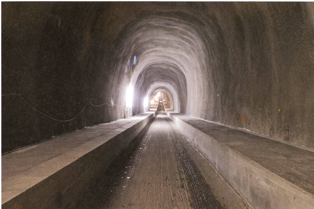
Parat für die Schienen: Der Tunnel im Rohbau kurz vor dem talseitigen Nordportal.
