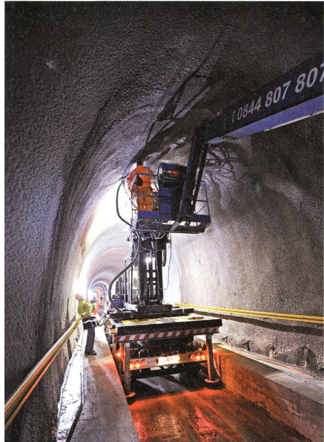
Der Tunnel wird mit Spritzbeton ausgekleidet.
