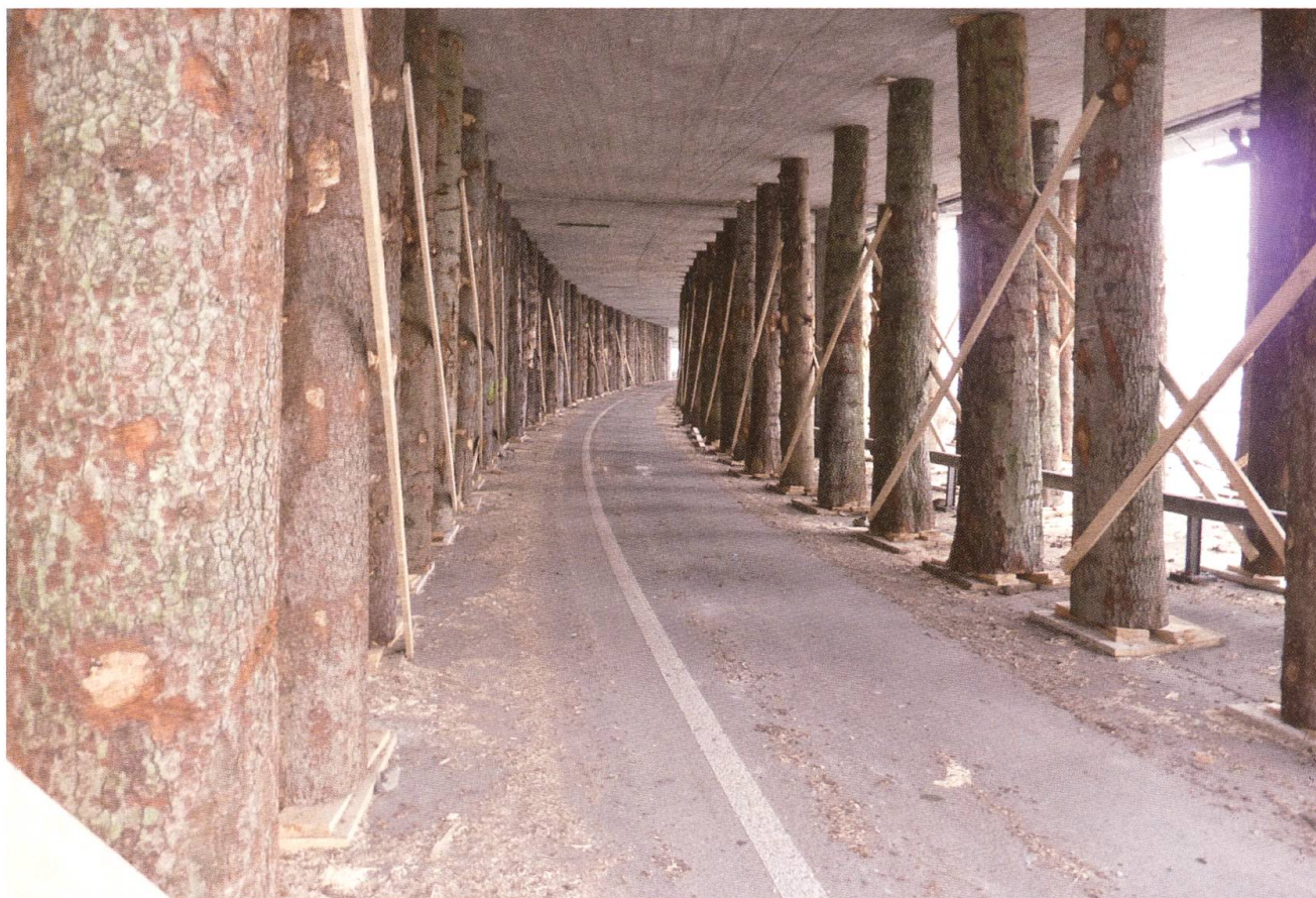
Über 300 Baumstämme stabilisieren den Viadukt im Hinblick auf mögliche Steinschläge.
