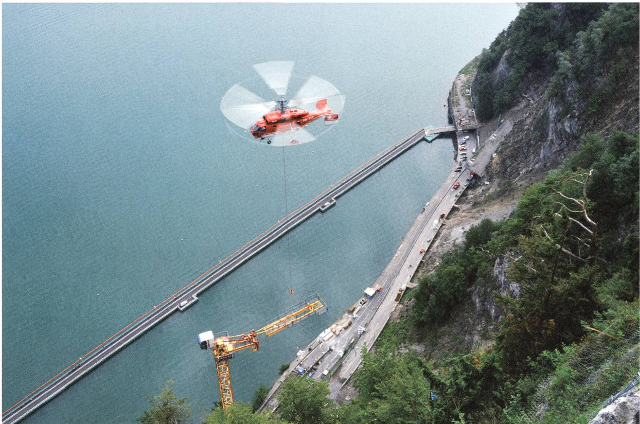
Ohne Helis geht es nicht: Fliegend wird der Kran auf Reigeldossen montiert.
