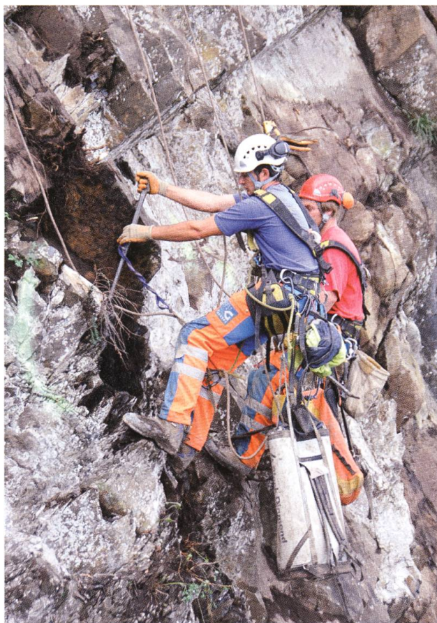
Mit Brecheisen wird der Fels untersucht.
