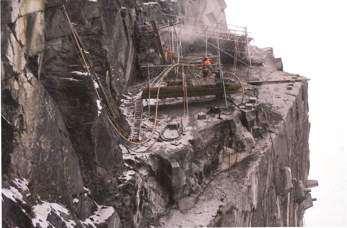
Hart an der Kante: Die Baustelle wird eingerichtet.
