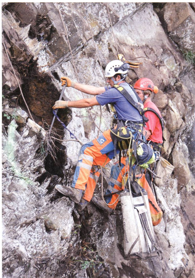
Mit Brecheisen wird der Fels untersucht.
