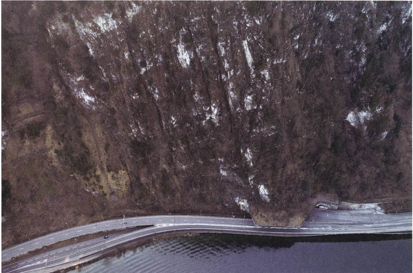
Gefahr von oben: Fast senkrecht erhebt sich der Fels über der Kantonsstrasse am Lopper.
