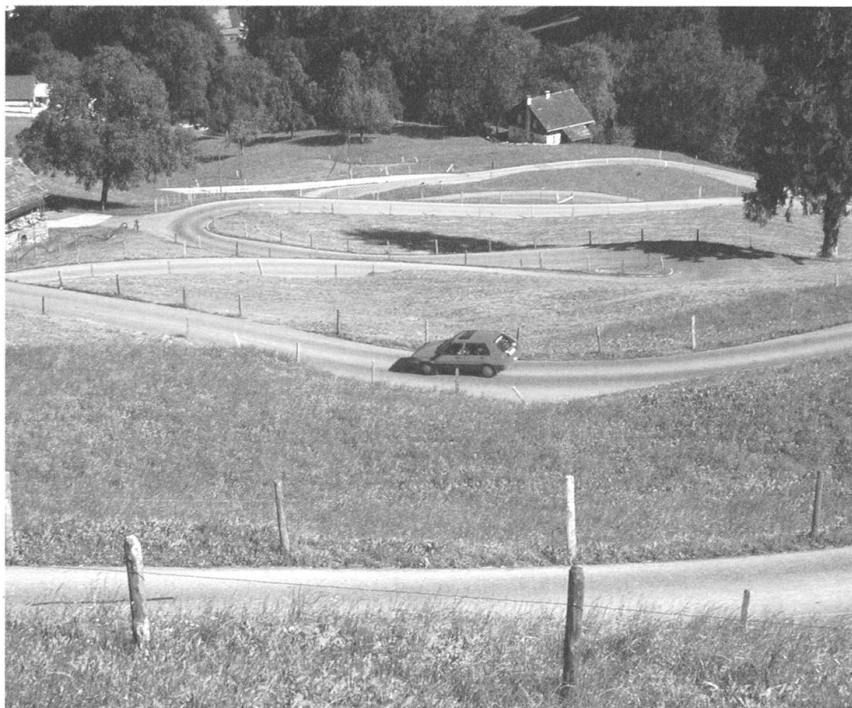
1.4. Die Sanierung der Wiesenbergstrasse verursacht sehr hohe Kosten.
