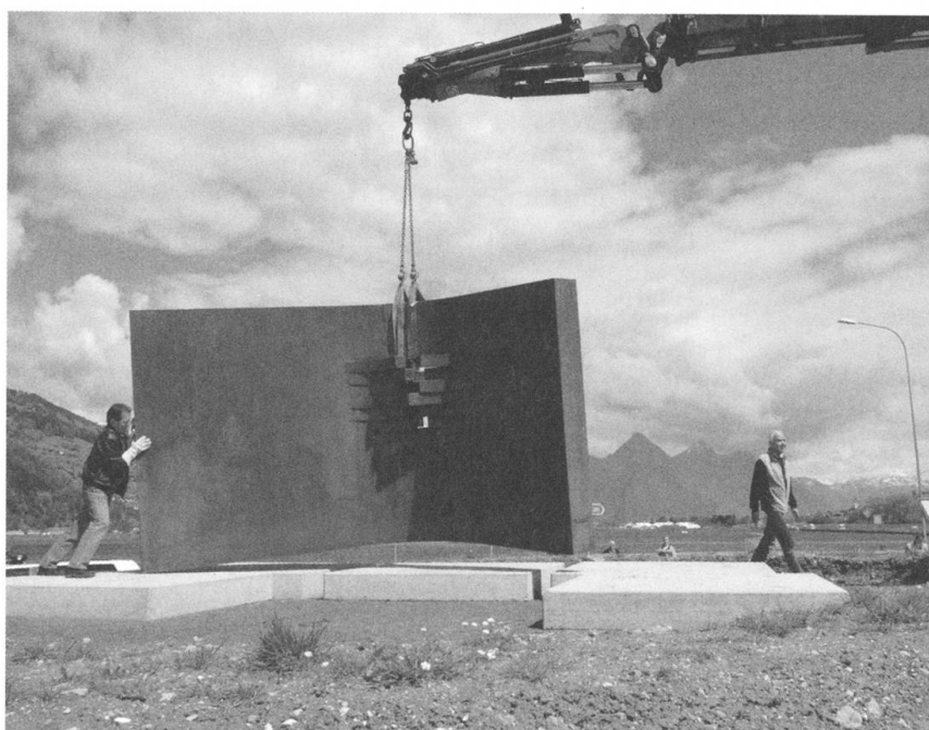
1.5. Die Eisenskulptur «Gebogene Wand» wird aufgestellt.
