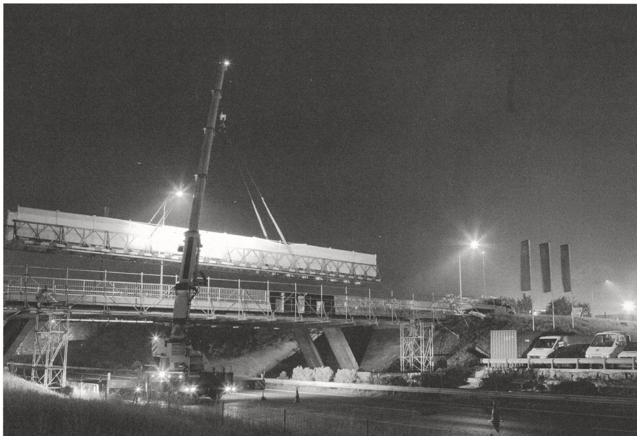
6.6. Montage der Fussgängerbrücke über der Autobahn bei der Kreuzstrasse in Stans.
