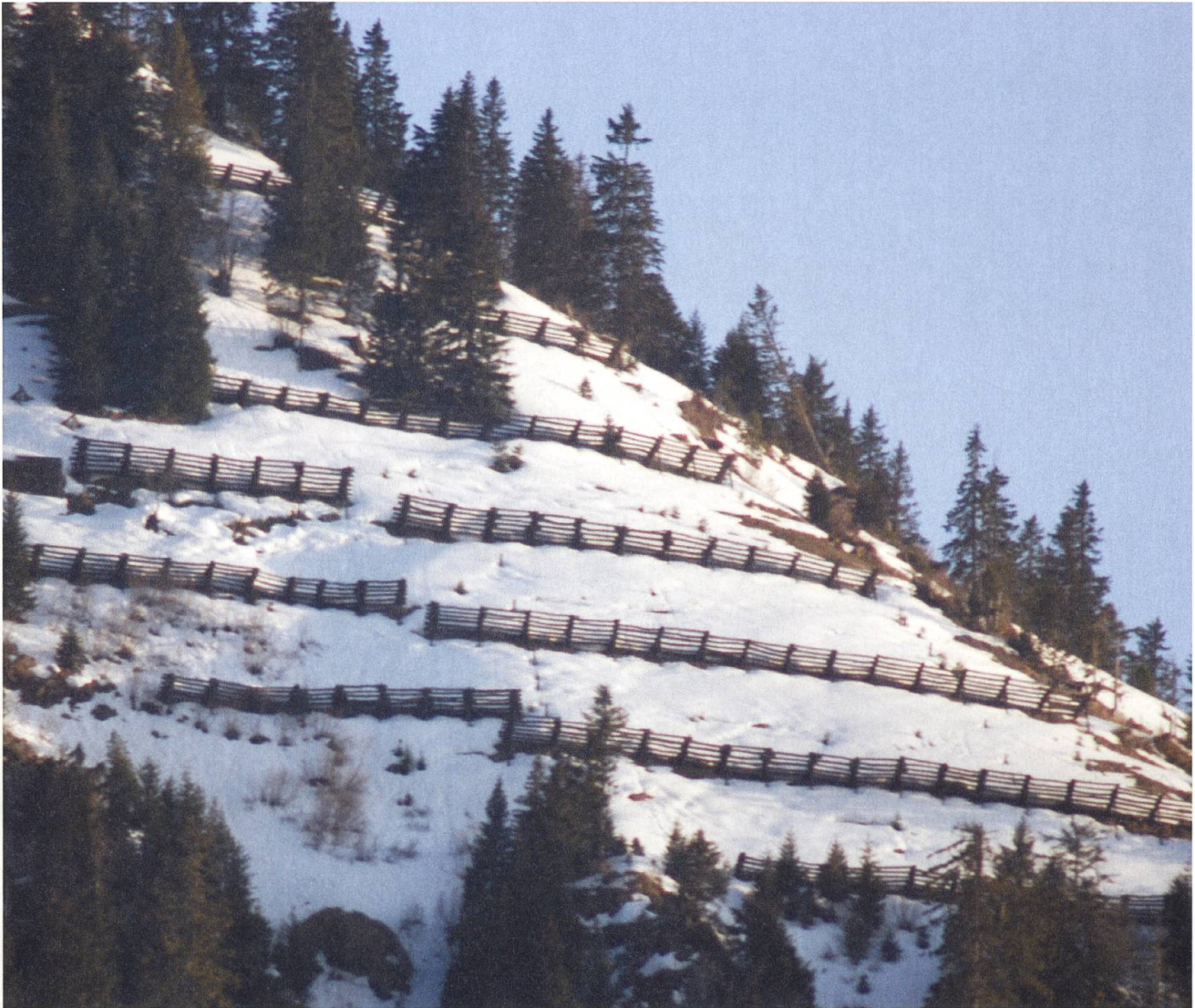
Wo der Wald nicht schützt, muss aufwendige Technik nachhelfen – wie mit Lawinverbauungen am Stanserhorn.
