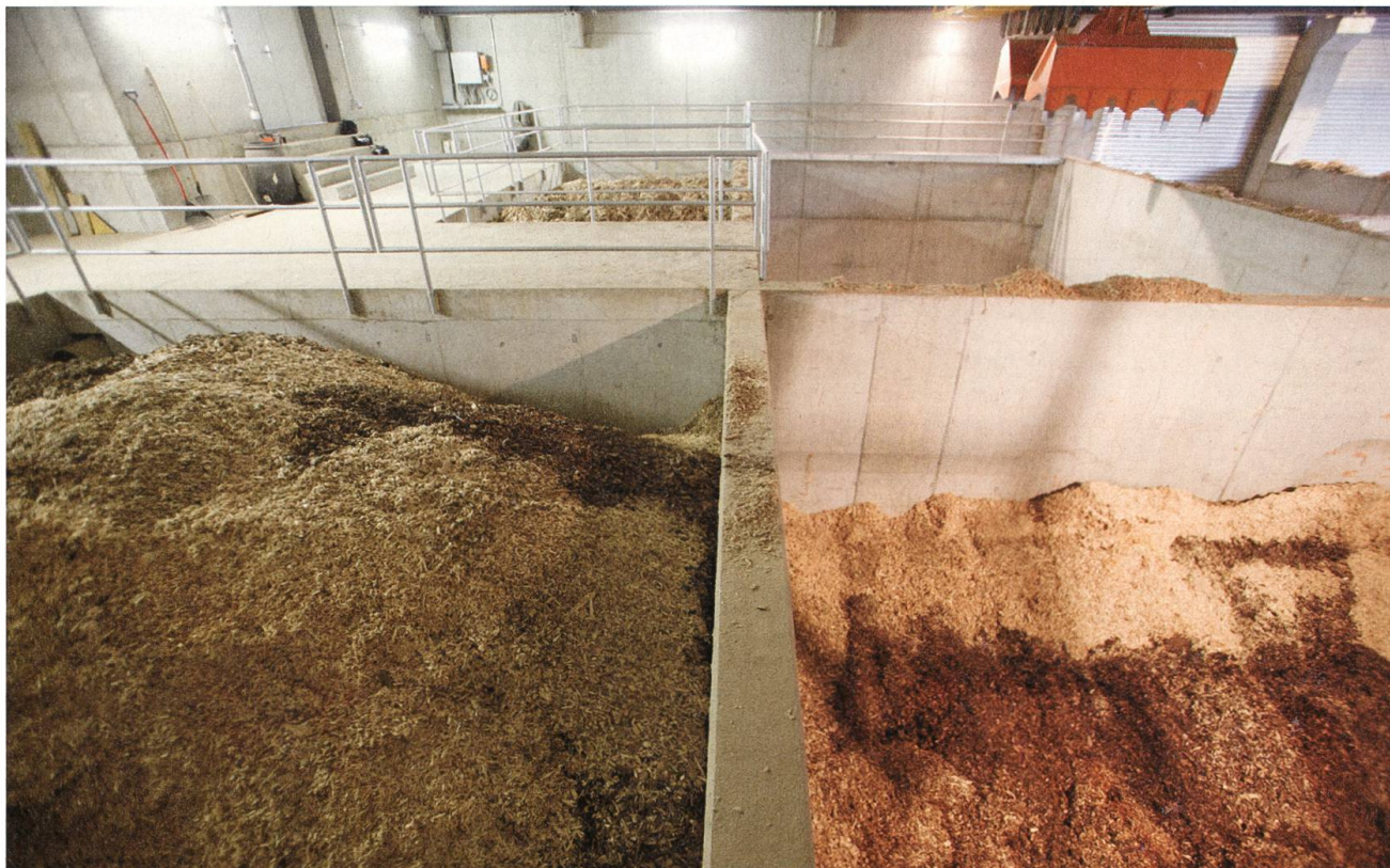
Blick ins Schnitzellager mit den Schubböden und dem ferngesteuerten automatischen Kran, der das Schnitzellager «bewirtschaftet».
