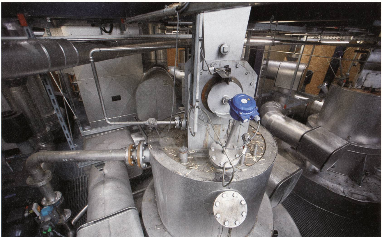
Die zweite Ebene in der Holzverstromung. Vorne das Mittelteil der Holzvergasung, die sich auf drei Ebenen ausdehnt.
