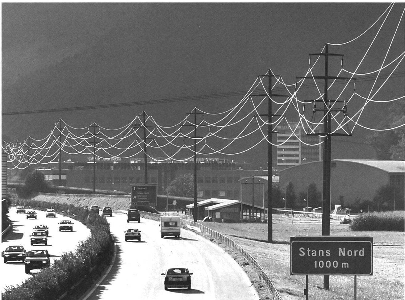
Ehemalige Hochspannungleitung des EWN über dem Eichli-Gebiet in Stans.
