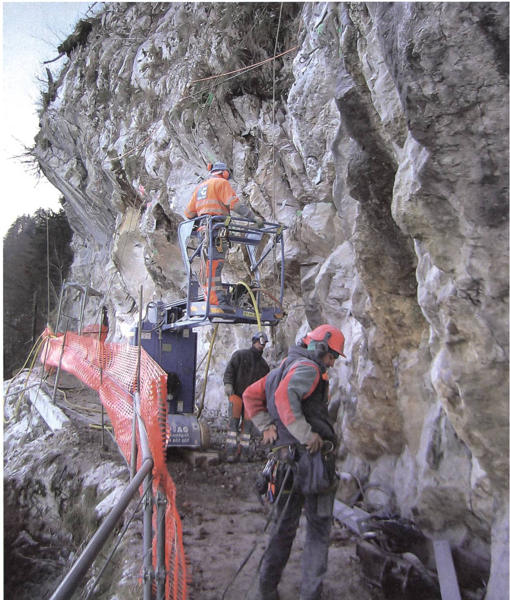
In zehn Monaten wurde der 2650 Meter lange Felsenweg umfassend saniert.
