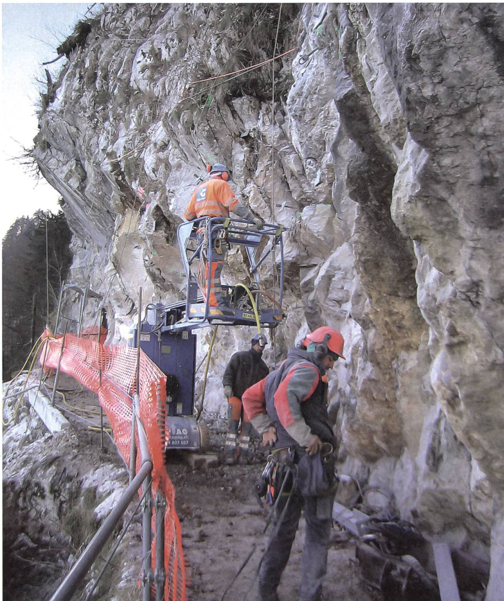
In zehn Monaten wurde der 2650 Meter lange Felsenweg umfassend saniert.
