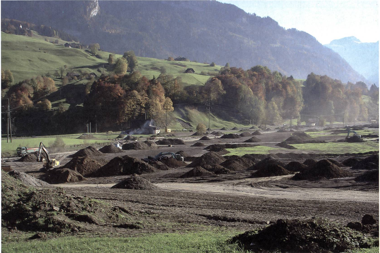
Räumung und Rekultivierung in der Ebene beim Fallenbach.
