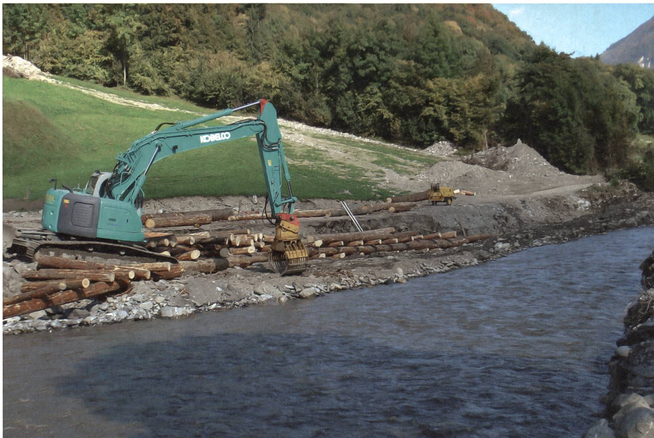
Bau eines Holzkastens bei Schroten.
