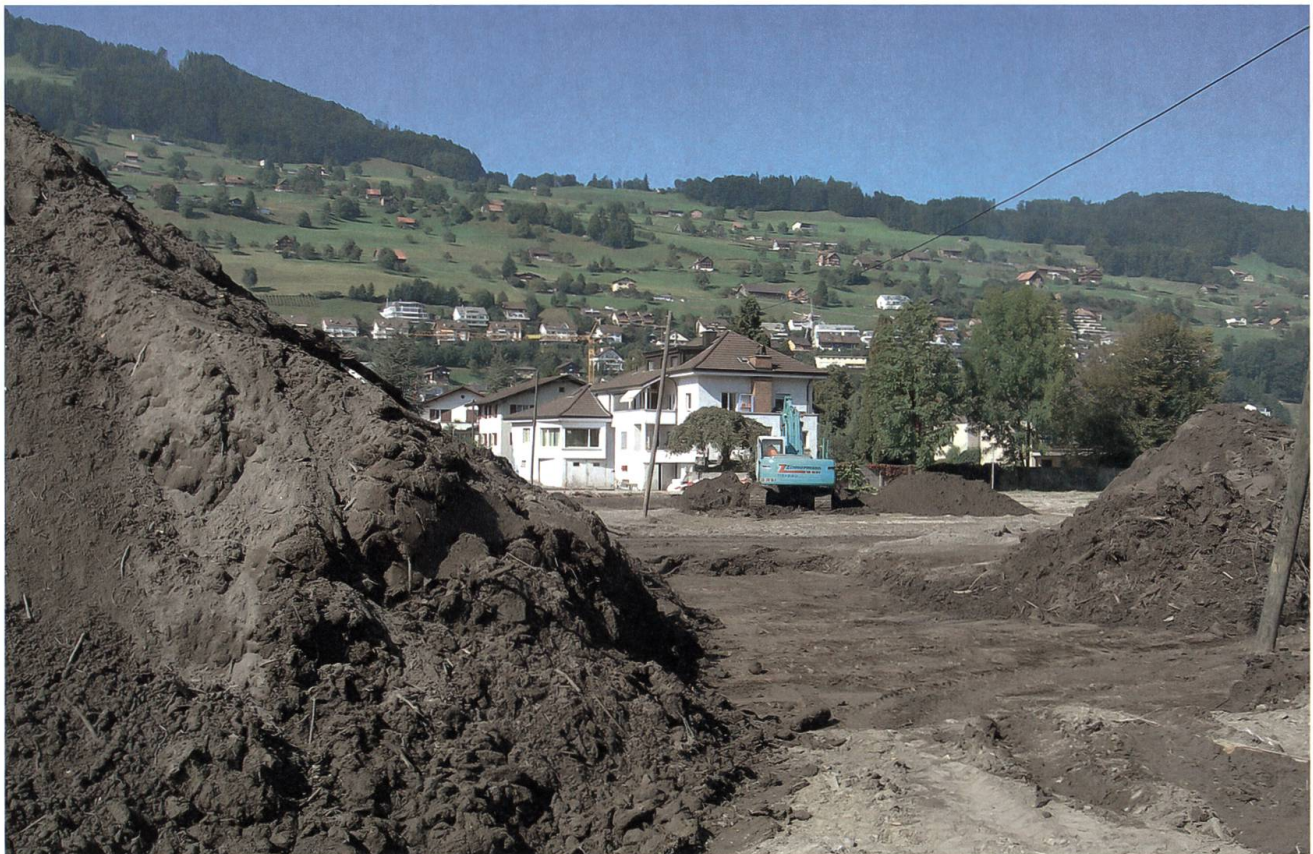
Räumung von 22'000 m 3 Sand, welcher im Entlastungskorridor abgelagert wurde.
