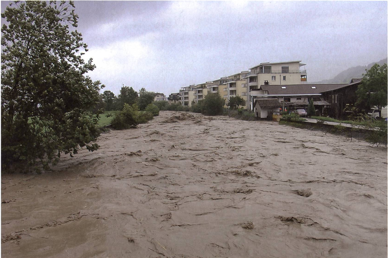
Dank der Entlastung des Aawassers konnte Buochs geschützt werden.
