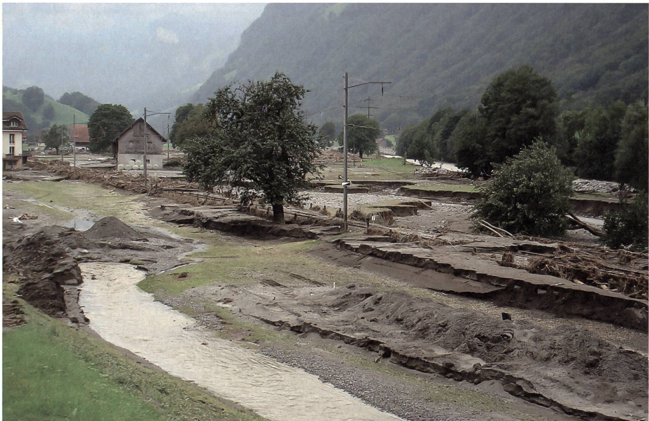
Wolfenschiessen, Dörfli: Zerstörung so weit das Auge reicht.
