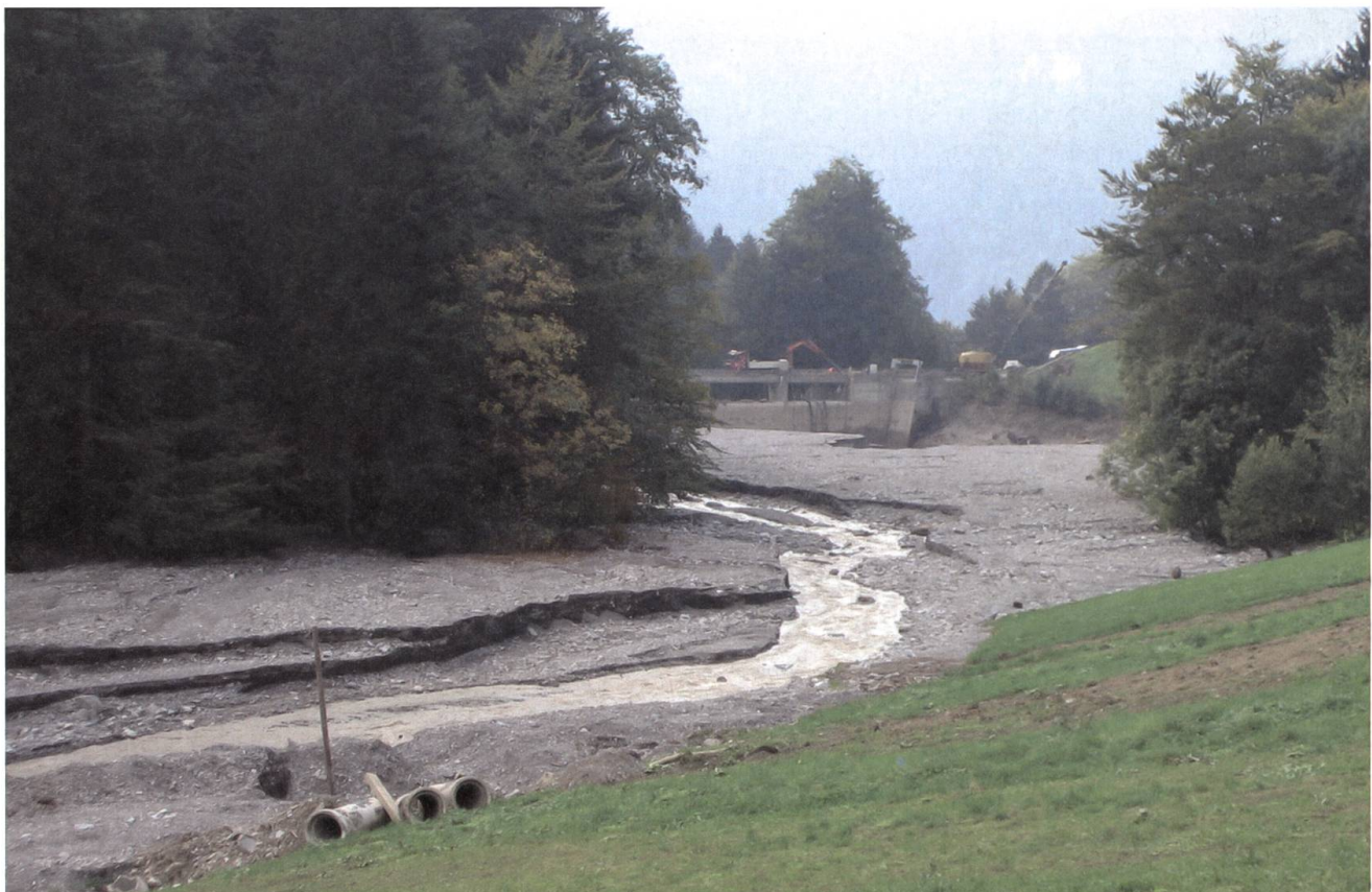
Geschiebeablagerung Secklisbach von rund 320'000 m 3 oberhalb der Staumauer vom Chäppelistutz.
