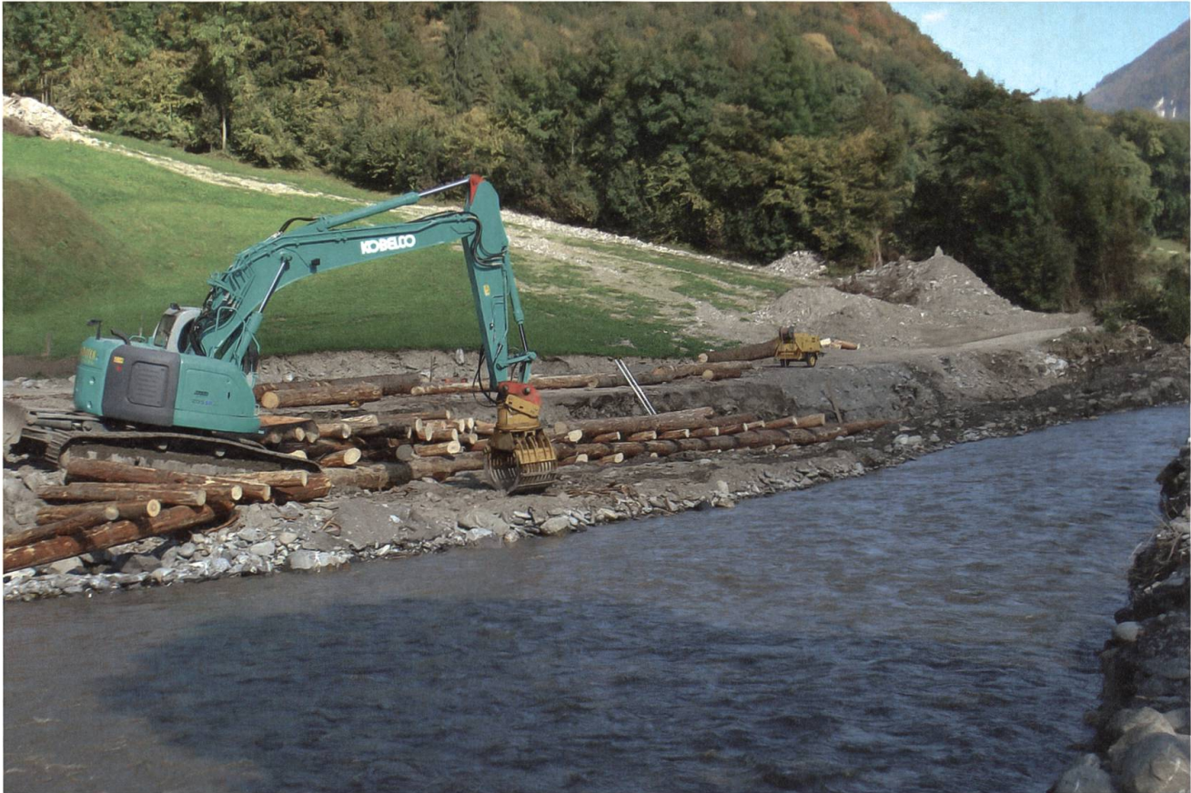
Bau eines Holzkastens bei Schroten.
