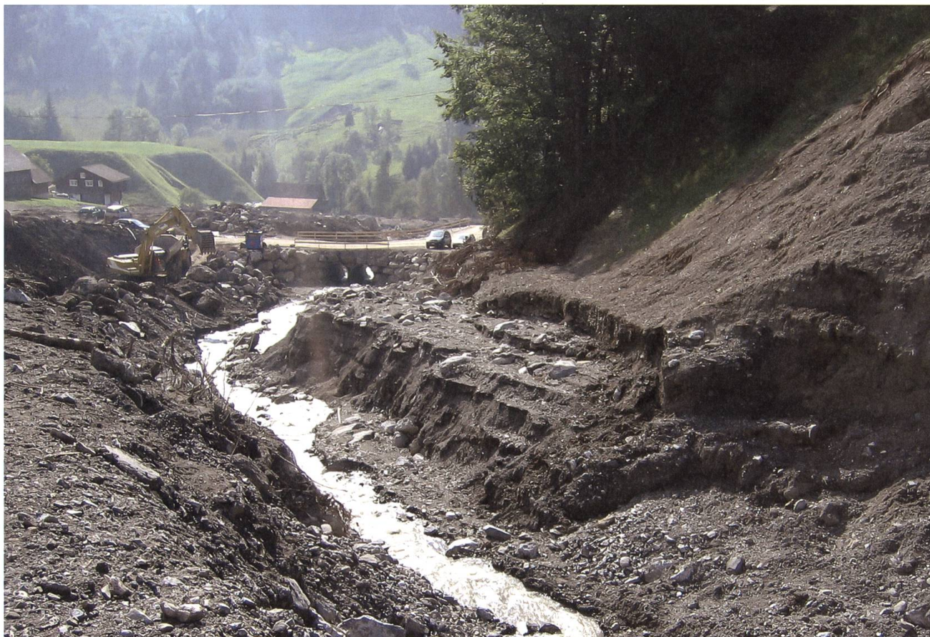
Haldibach, Oberrickenbach: Aufbau des Fusses für den oberen Schutzdamm oberhalb der Notbrücke.
