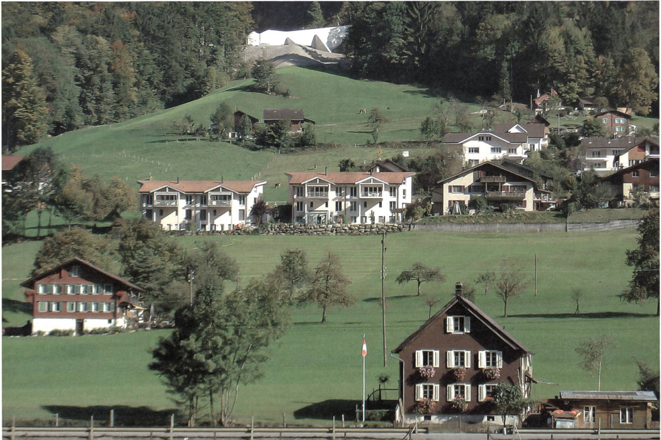
Geschiebesammler Humligenbach, im Juli 2005 fertiggestellt, schützt das Wohngebiet auf dem Schwemmkegel.
