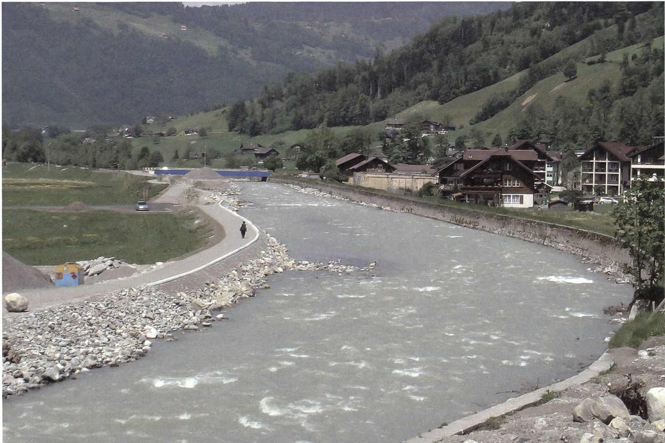
Mehr Raum für das Aawasser bei Büren (Stand Sommer 2006).
