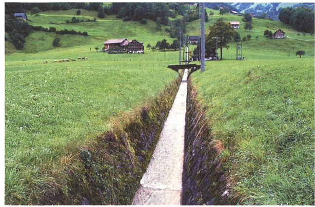
Abbildungen 9 bis 10. Dem Scheidgraben Buochs/Ennetbürgen (links) kommt in diesem Abschnitt die Einstufung «stark beeinträchtigt» zu. Gründe dafür sind: keine Sohlen- und Wasserspiegelvariabilität, verbauter Böschungsfuss, kein Uferbereich, keine Bestockung. «Naturfremd, künstlich» ist die Klassierung des Krätligbaches in Dallenwil (rechts). Ihm fehlen in diesem Abschnitt alle Eigenschaften, die einen funktionierenden Bach in ökologischer Hinsicht ausmachen.
