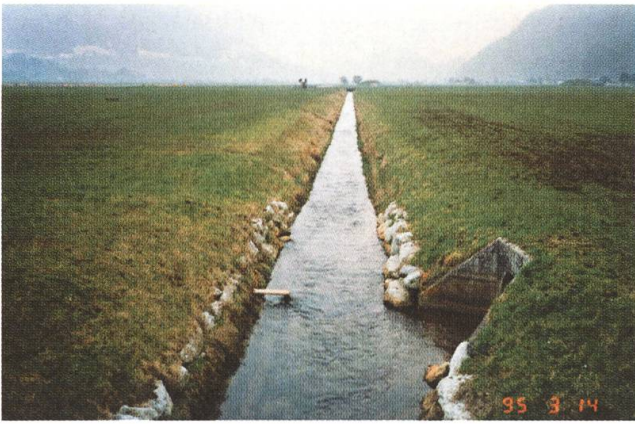
Abbildungen 9 bis 10. Dem Scheidgraben Buochs/Ennetbürgen (links) kommt in diesem Abschnitt die Einstufung «stark beeinträchtigt» zu. Gründe dafür sind: keine Sohlen- und Wasserspiegelvariabilität, verbauter Böschungsfuss, kein Uferbereich, keine Bestockung. «Naturfremd, künstlich» ist die Klassierung des Krätligbaches in Dallenwil (rechts). Ihm fehlen in diesem Abschnitt alle Eigenschaften, die einen funktionierenden Bach in ökologischer Hinsicht ausmachen.
