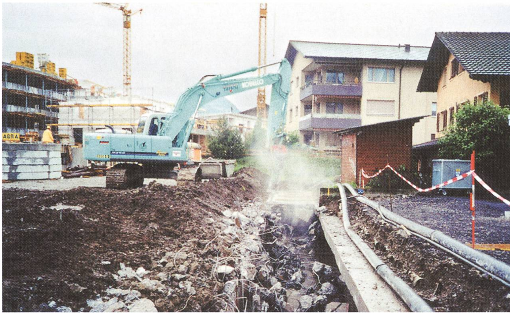
Revitalisierungsbeispiel. Abbildung 20. Schöpfgraben, Buochs. Bei der Schützenmatte wurde ein Teilstück des eingedolten Bachens ans Licht geholt.
