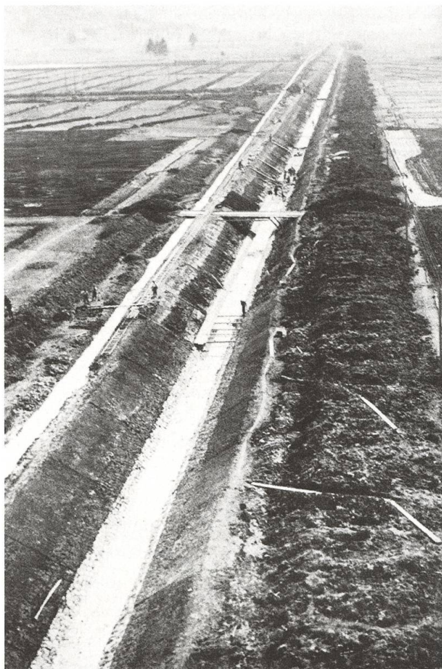
Abbildung 3. Melioration des Drachenrieds Ennetmoos während des 2. Weltkrieges. Der Melbach wurde begradigt und die Bachsohle mit einer durchgehenden Bruchstein-Trockenpflasterung verbaut. Foto Bauzustand 1942.
