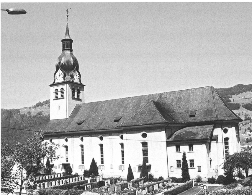
13.08. Neues Dach für die Buochser Pfarrkirche
