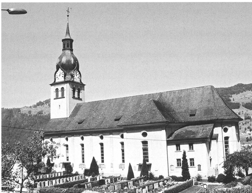
13.08. Neues Dach für die Buochser Pfarrkirche
