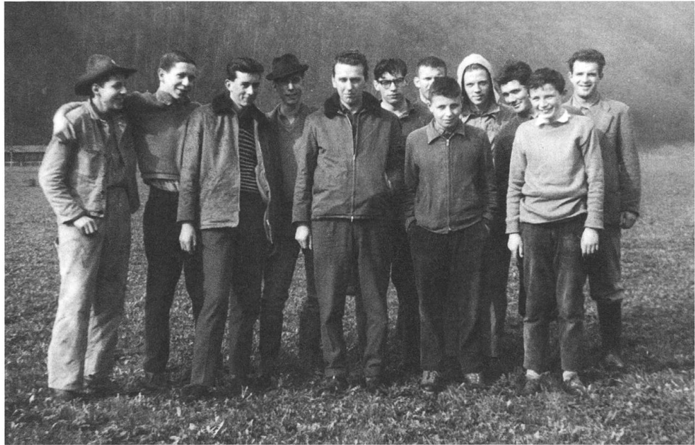
Fronmannschaft vom BSV im Eichli (Planierungsarbeiten), 1963.
