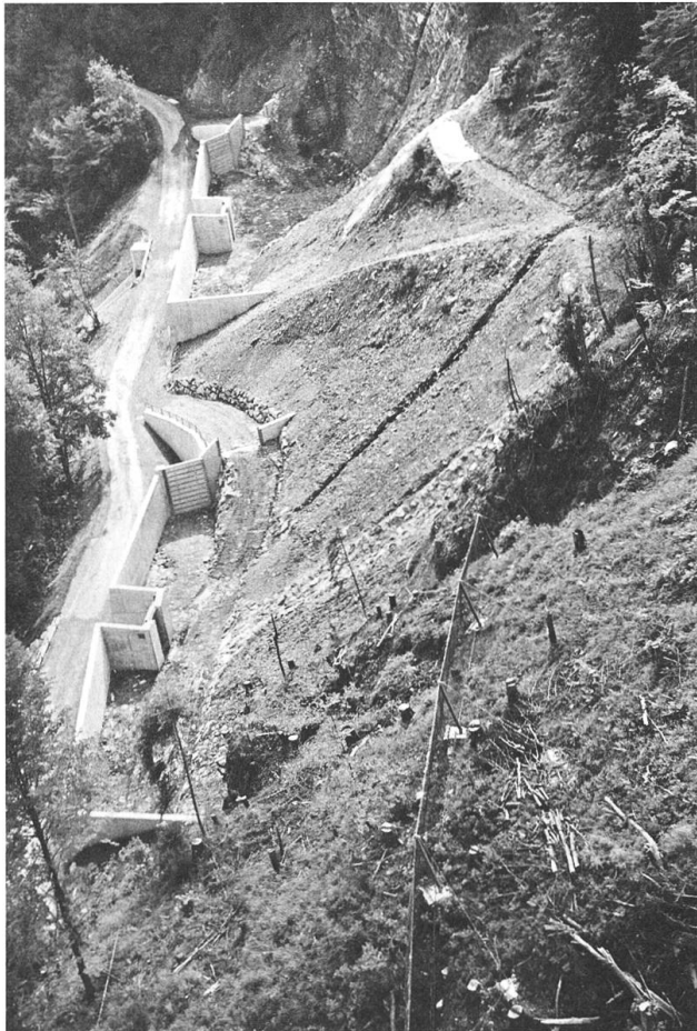
Übersicht über die Geschiebesammler Kellbach I + II. Die bergseitigen Steilrampen ermöglichen die Zufahrt der Bagger. Nach der Freilegung des untenliegenden Schotts der Öffnungen können die Lastwagen in den Sammler nachgezogen werden. Die Werkstrasse 3 wurde verbreitert, damit Lastwagen warten und kreuzen können. Im Bildvordergrund ist eines der Steinschlagnetze zu sehen.
