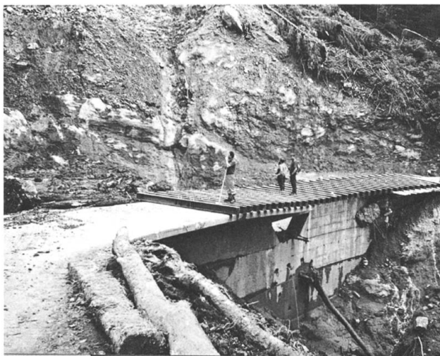
Hinter-Erlibach III nach der Räumung und der Montage der Stahlträger zur Überbrückung der zerstörten Brückenplatte.
