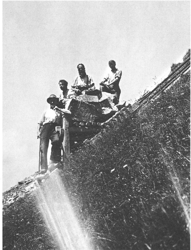
Die Steinblöcke wurden aus einem «Steinbruch» im Gebiet Gigi mit einer eigens konstruierten Bahn zum Bauplatz gebracht.
