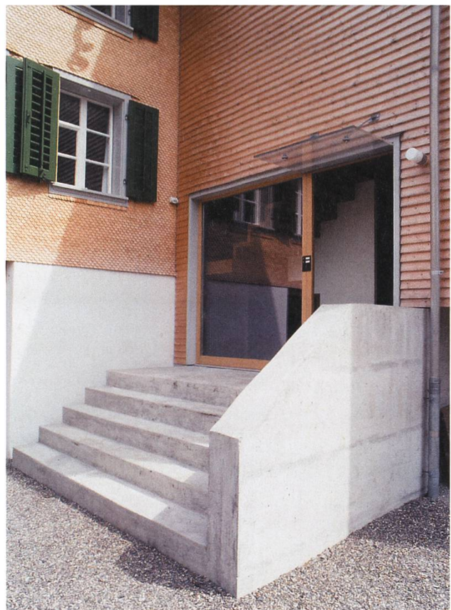
Stansstad, Wohnhaus Schürmatt; Detail der Eingangspartie.
