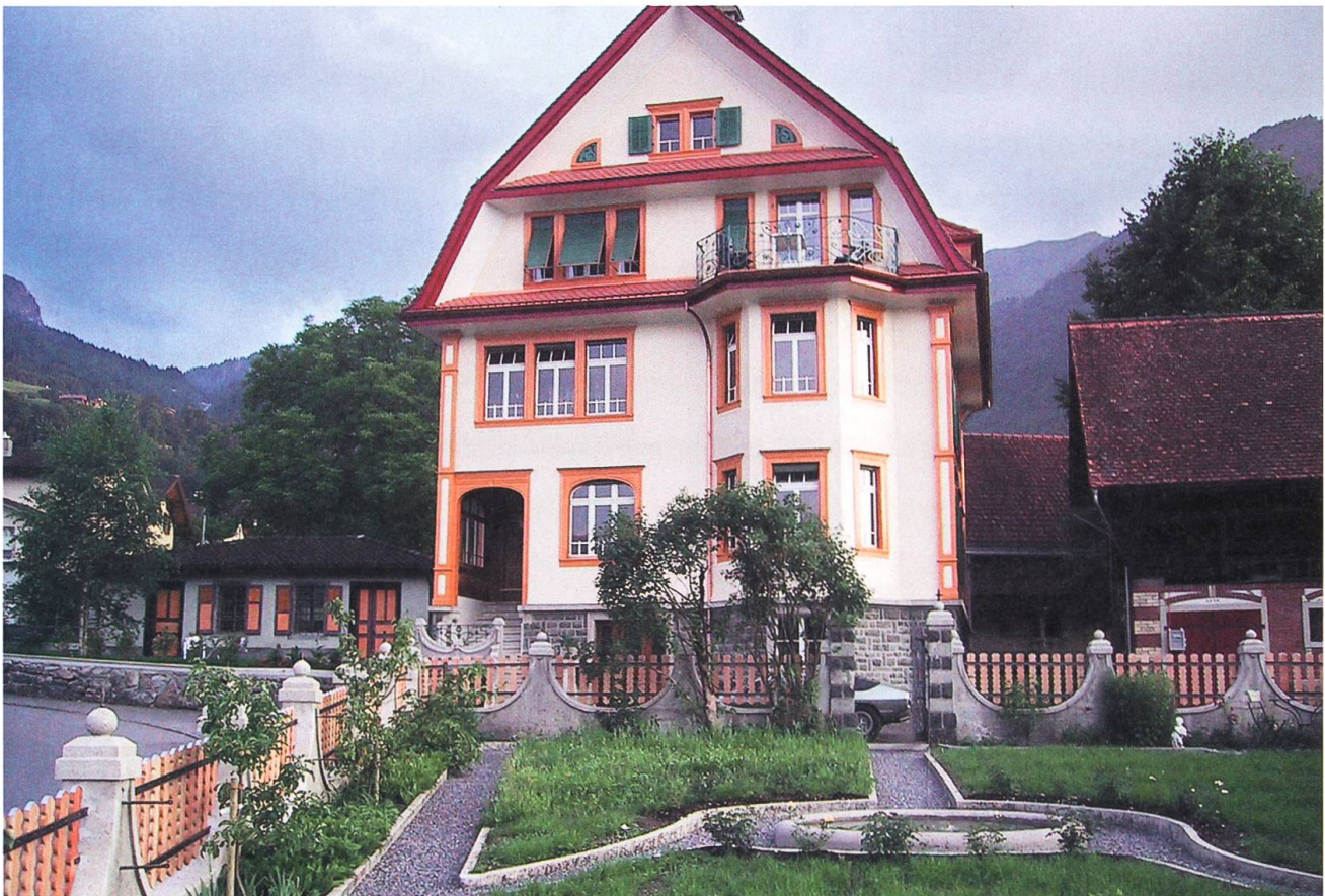
Beckenried. Wohnhaus Rütistrasse 18; Aussenansicht.
