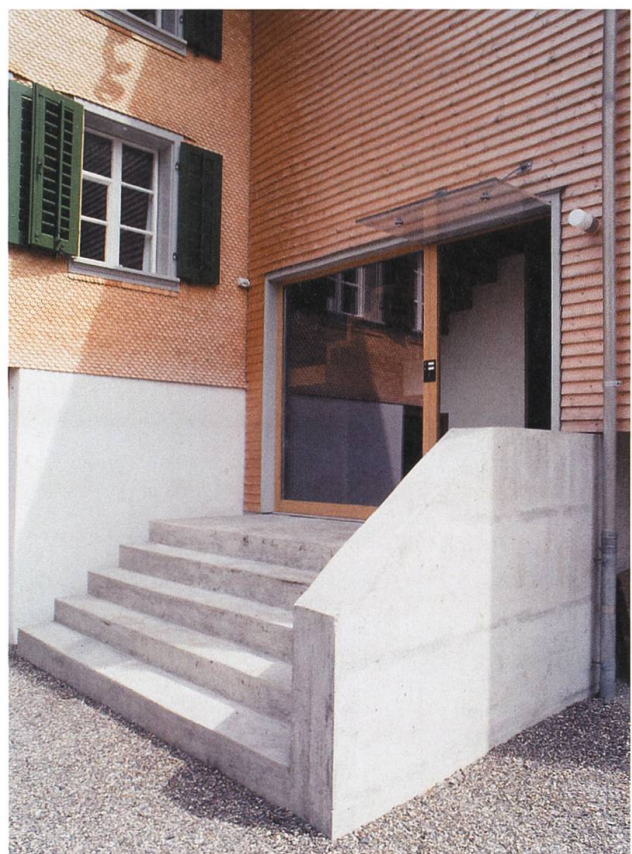
Stansstad, Wohnhaus Schürmatt; Detail der Eingangspartie.
