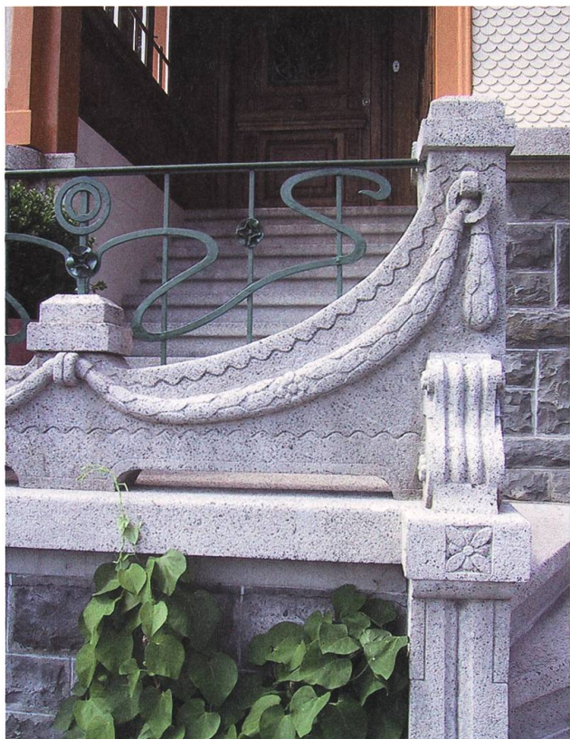
Beckenried. Wohnhaus Rütistrasse 18; Detail der Eingangspartie.
