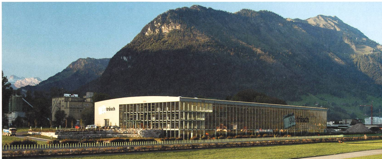
Das neue Produktionswerk in Buochs
