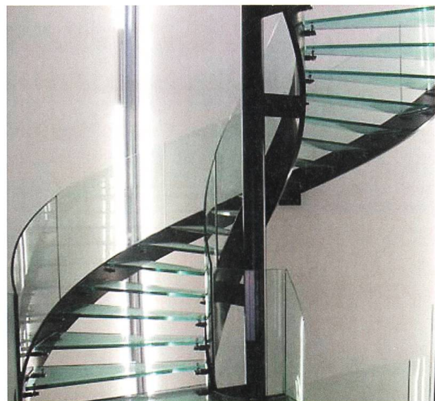
Innenausbau (verglaste Treppe im Werk Buochs)
