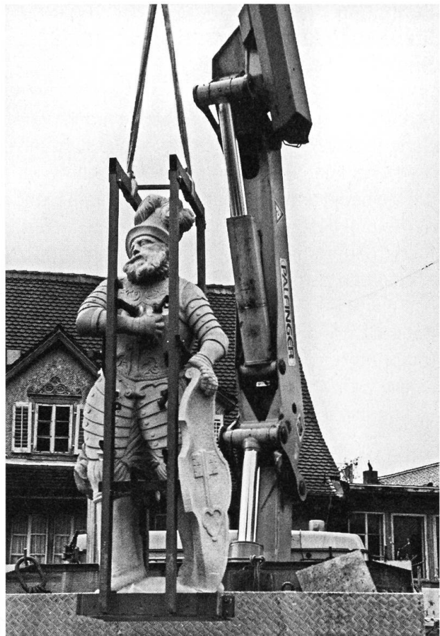
Stans. Winkelriedbrunnen, Restaurierung
