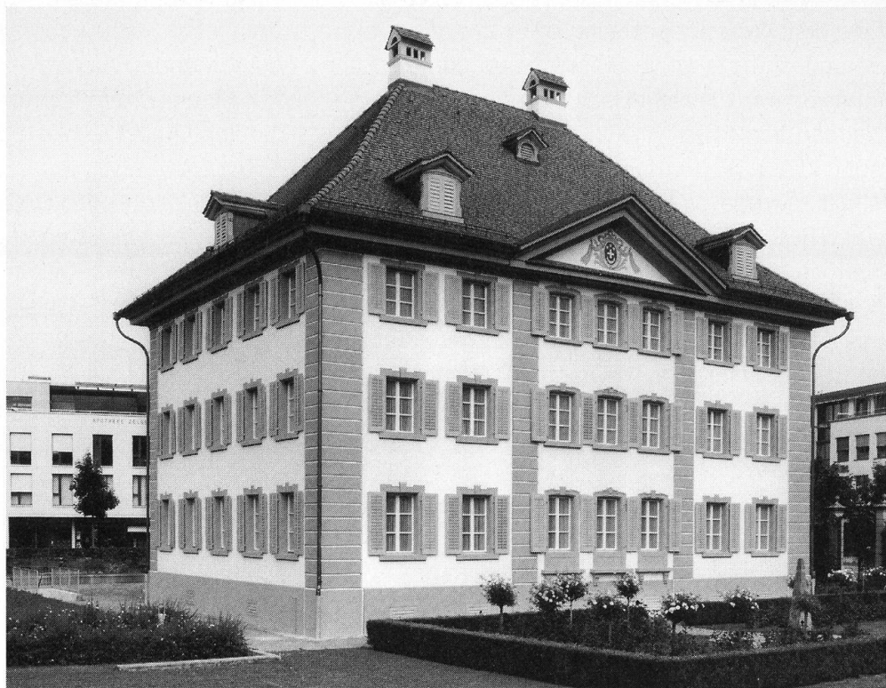
Stans. Breitenhaus, Aussenrestaurierung
