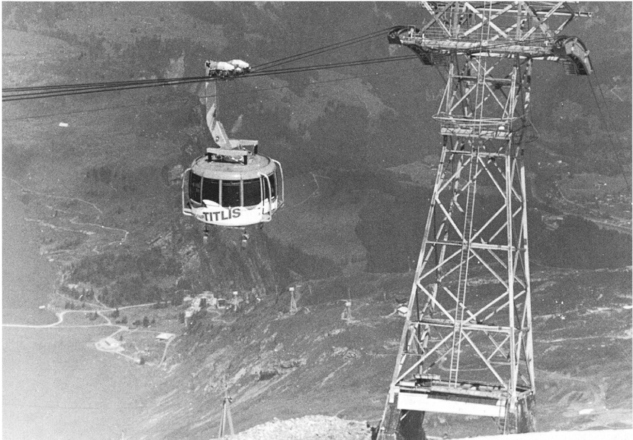
Am 15. März 1967 war es soweit. Zum ersten Mal eroberte eine Luftseilbahn in der Schweiz einen Dreitausender mitten im ewigen Eis des Titlisgletschers. Diese Bahn wurde später durch die erste drehbare Luftseilbahn der Welt, Rotair, ersetzt.
