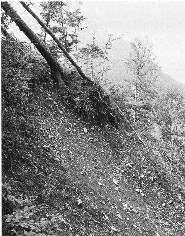
Bis der freigelegte Boden durch neue Wurzeln wieder «armiert» ist, dauert es Jahre (Zilibach, Büren).
