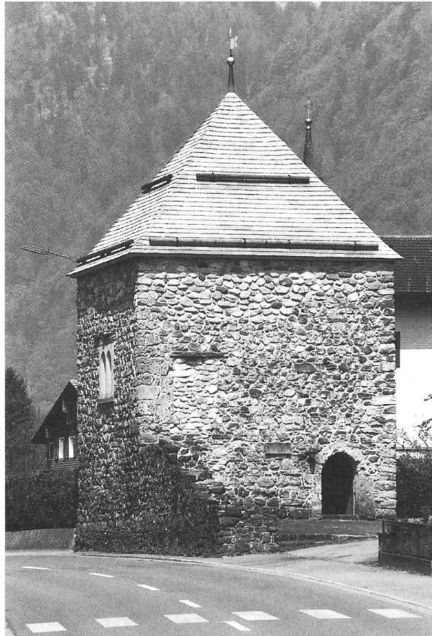
Wolfenschiessen. Burgruine Dörfli. Ansicht von Süden nach der Restaurierung.
