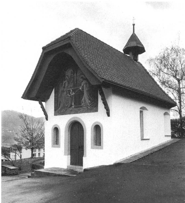
Buochs. Nothelferkapelle. Aussenansicht von Westen. Zustand nach Restaurierung.
