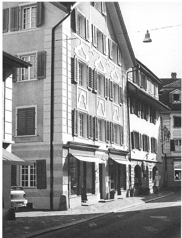
Stans. Wohnhaus Engelbergstrasse 1. Ansicht von Westen nach der Restaurierung.
