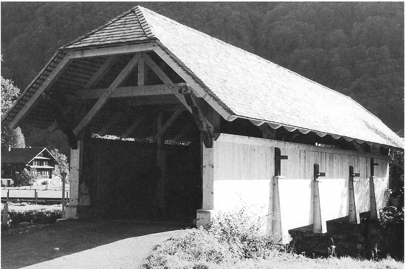
Wolfenschiessen. Holzbrücke über die Engelbergeraa. Ansicht nach der Restaurierung.
