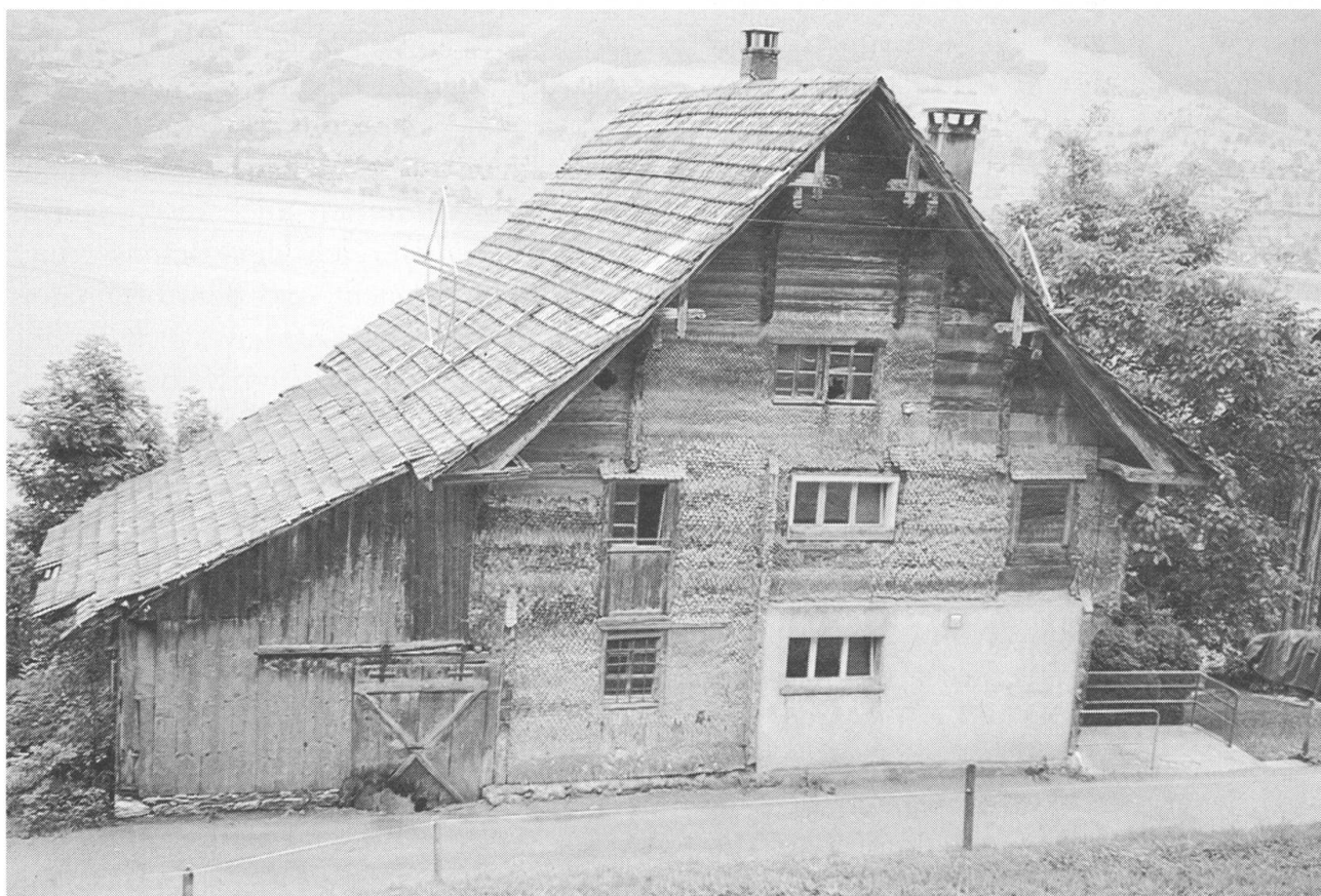
«Regenrüti»-Haus im Buochli, Ennetbürgen, vor der Restaurierung.
