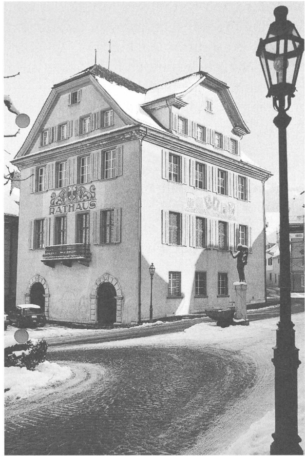
Stanser Rathaus, Nordwest- und Südwest-fassade
