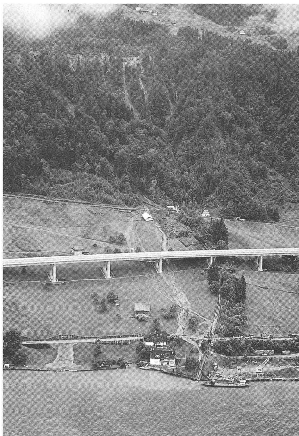
15. Juni 1999 Übersicht über den westlichen Teil der Ischenwald-Rutschung mit dem Einzugsgebiet des Hinter-Erlibaches. Von oben nach unten: Anrissgebiet bei Waldgrenze, Abbrüchen an der Steilstufe, Murganggerinne im Wald und Übermürungen unterhalb Emmetterstrasse, niedergedrückter Stall beim Grünenwald, Ablenkpalisaden und Bagger beim Freihalten des Gerinnes.
