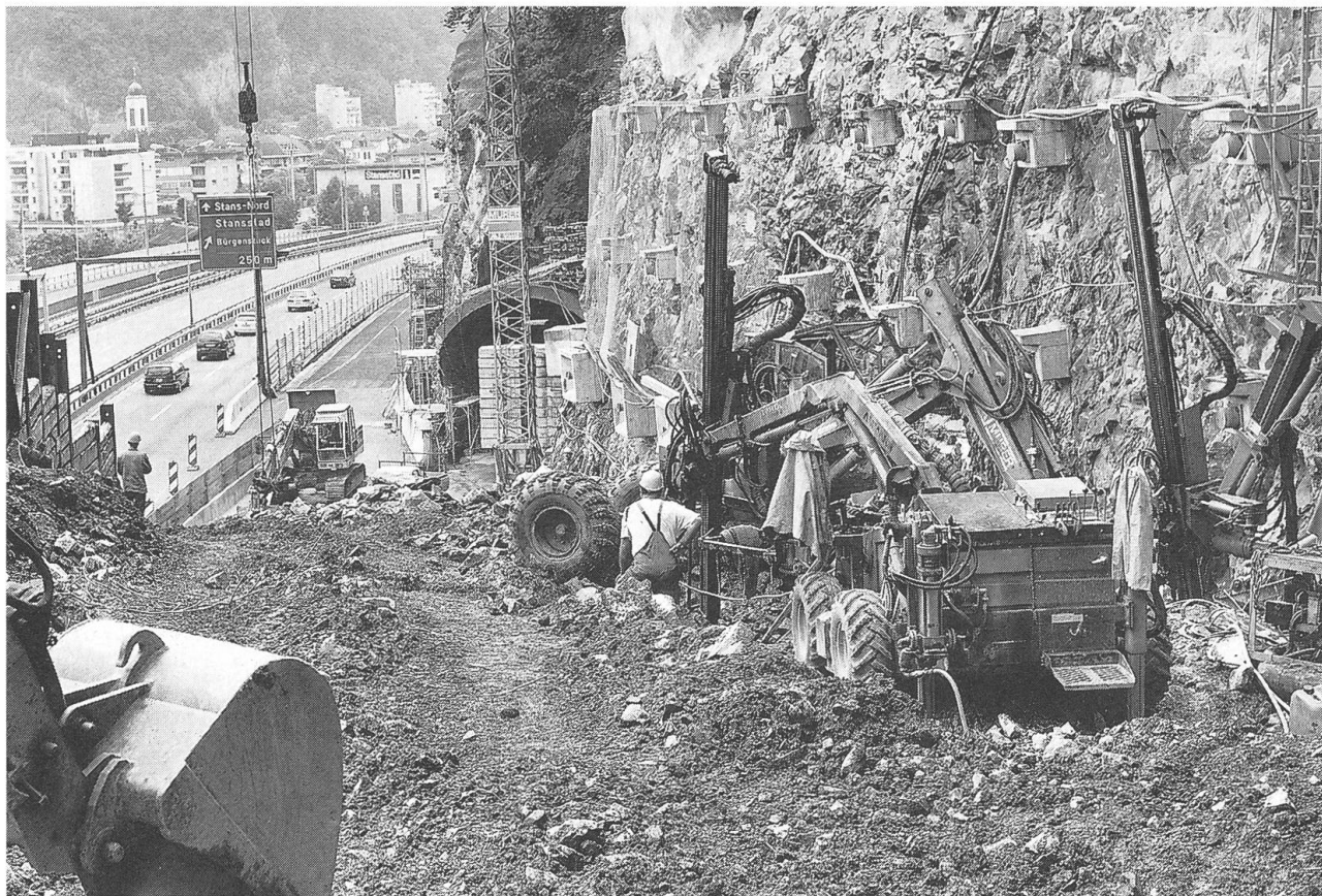
Die Portalzone des Kirchenwaldtunnels auf Stansstader Seite.
