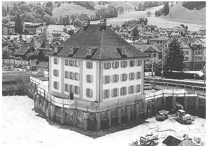
dieser Zeit gemacht. Nun wurde sichtbar, wie die grosse Bohrmaschine auf der Fahrt rings um die Baugrube einen Betongürtel goss. Das Breitenhaus steht sozusagen auf einer Halbinsel. Die dort einquartierte Baudirektion kann aber «vom Land her» in die Büros, denn das Grundwasser wurde vorsorglich abgepumpt.
