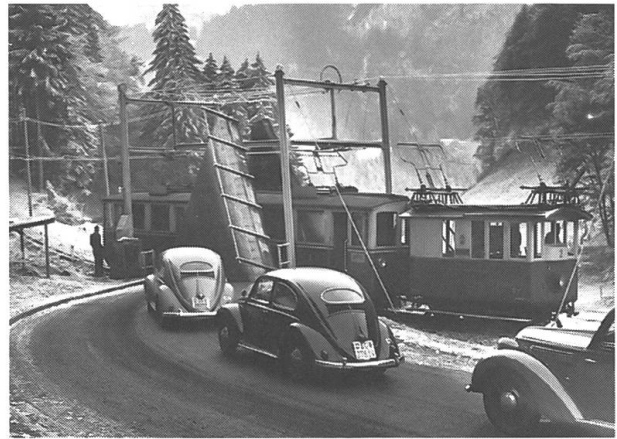
Bis zum Abbruch 1962 war die Klappbrücke bei Grünenwald weltbekannt.
