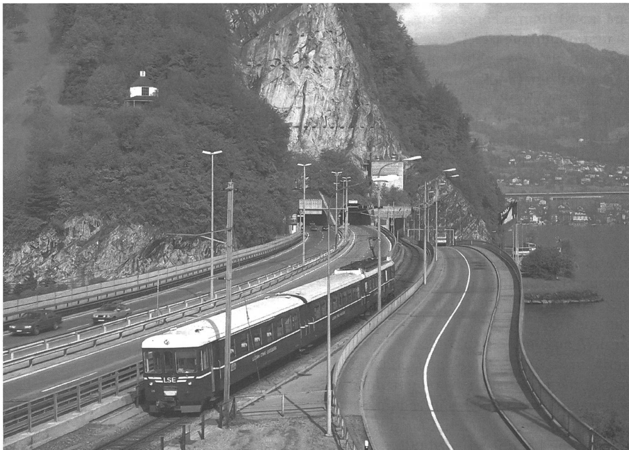
Achereggbrücke in Stansstad mit Autobahn, LSE und Lokalstrasse
