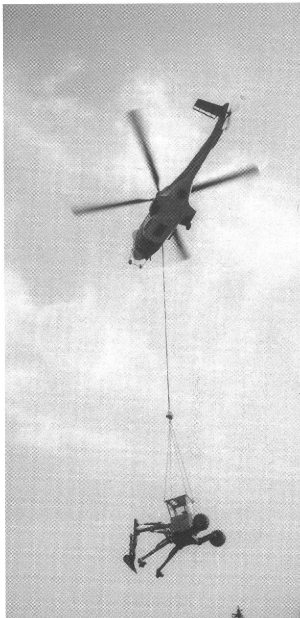
Mit dem Super-Puma wird die Baumaschine leicht und schnell transportiert.
