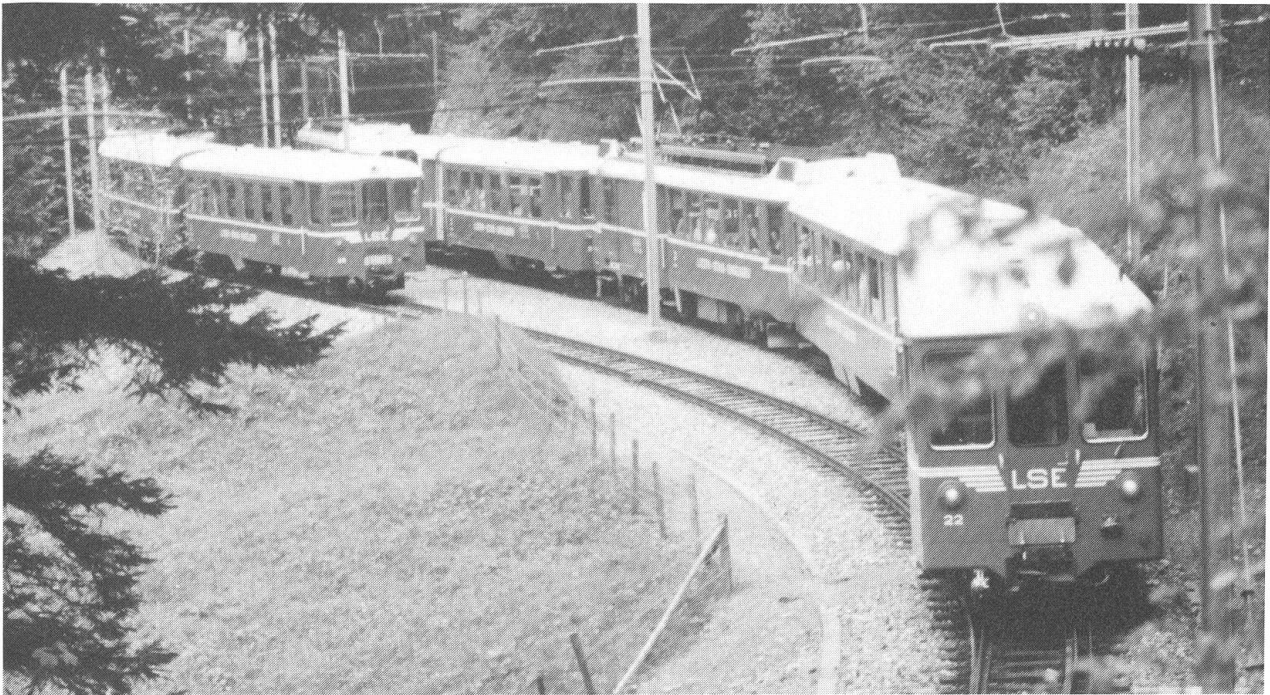
Ausweichstelle Ghärst mit knappen Kreuzungsverhältnissen am Ende der Zahnstange Richtung Engelberg, die gegenwärtig für 1,3 Millionen Franken ausgebaut und den Bedürfnissen der Bahn 2000 angepasst wird.
