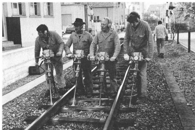
Bahnunterhaltsgruppe mit Schotter-Stopf-Geräten.
