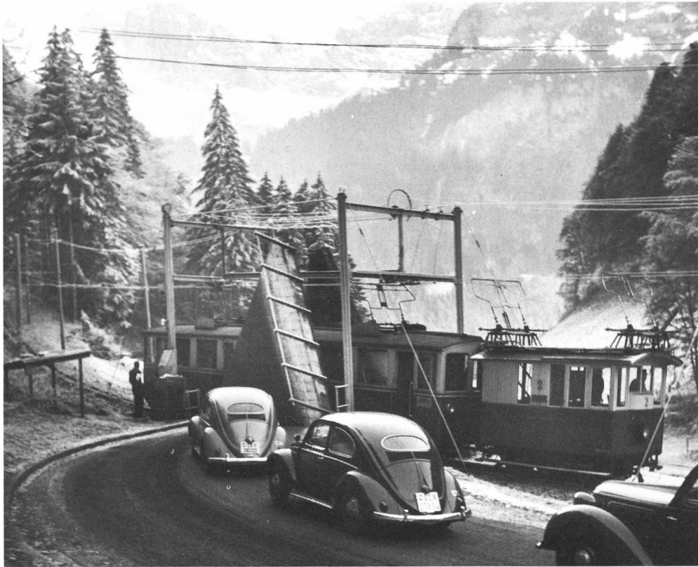
Klappbrücke bei Grünenwald, die bis zum Bau der neuen Kantonsstrasse 1962 in Betrieb war.
