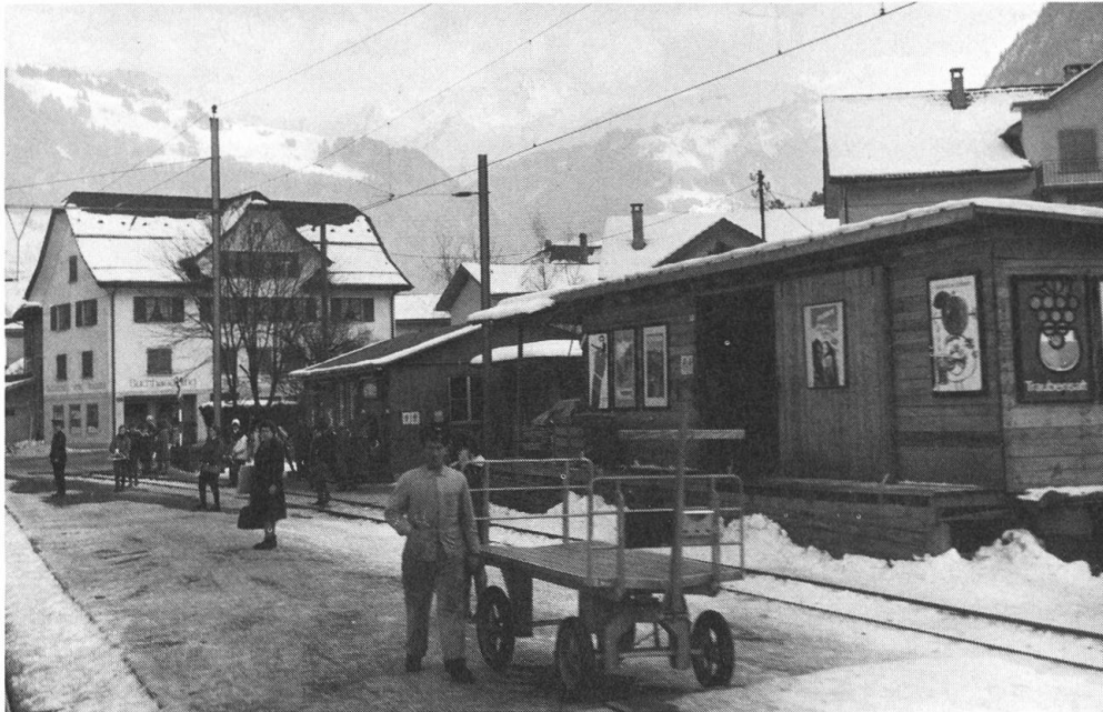
Das Bauprovisorium auf der Station Stans, bis am 1. August 1965 die neuen Stationsräumlichkeiten bezogen werden konnten.
