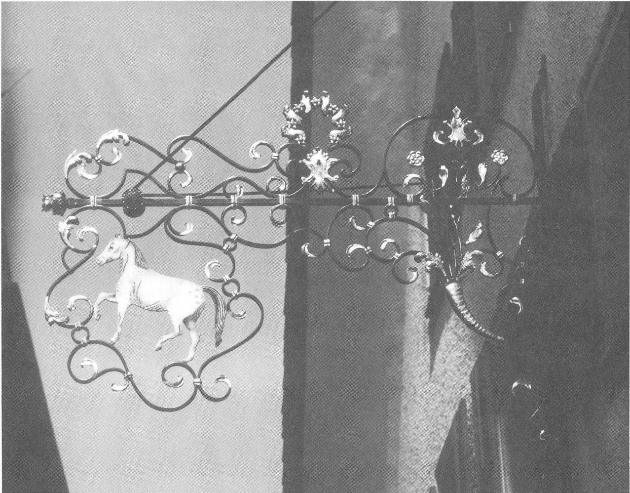
Hotel Rössli in Beckenried: Entwurf und Ausführung: Hans-Ueli Baumgartner, Beckenried (1980). Ausladung: 2,5 m. Gewicht: zirka 160 kg. Tragkonsole aus Vierkanteisen, die ganze Verzierung aus Flacheisen mit ausgeschmiedeten Enden in Blattform. Füllhorn mit geschmiedeten Blumen aus Rundeisen. Blätter und Rosetten aus Stahlblech geschmiedet. Rössli aus einem 10 mm Stahlblech geschmiedet. Behandlung: farbig und vergoldet.
