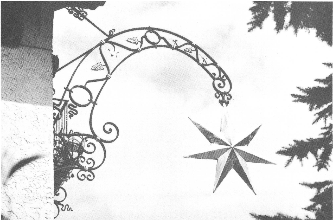
Sternen Beckenried: Entwurf: Bruno Leuthold, Stans, Ausführung Gebrüder Leuthold, Stans. Weitausragender Ausleger aus vierkanteisen mit wellförmigen und kreisrunden Zwischenverbindungen verziert mit Traubenständen. Der grosse aus Eisen getriebene siebenzackige Stern als flachrelief geschmiedet und vergoldet.
