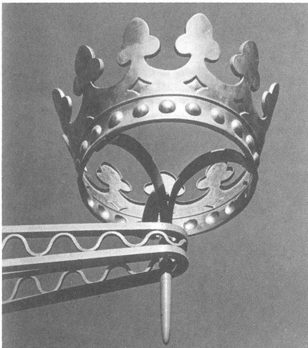
Krone Stans: Entwurf: A. Boyer, Luzern. Ausführung Gebrüder Leuthold, Stans. Schmiedeeiserner Ausleger mit getriebener Leichtmetallkrone, eloxiert.
