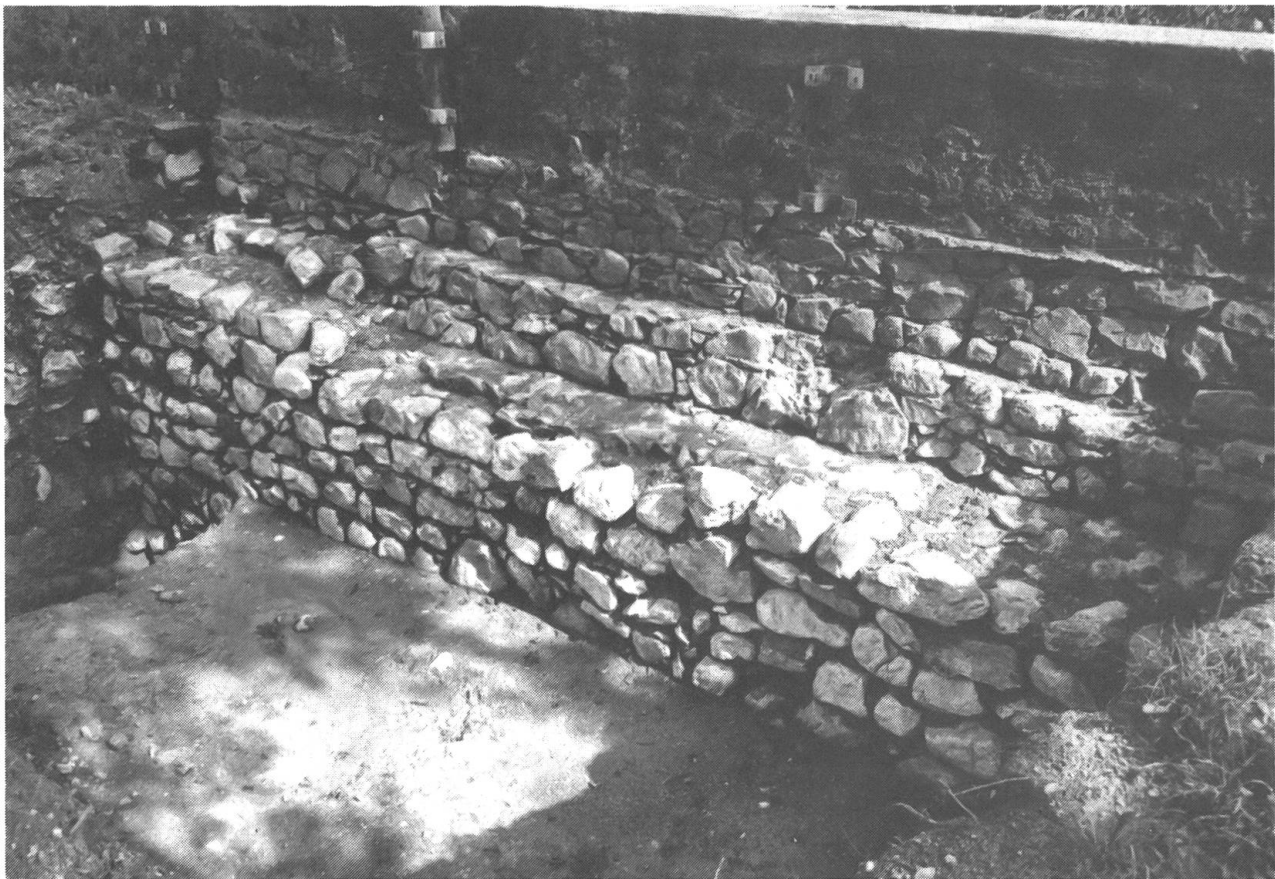
Teil der umfassenden Ringmauer aus dem 11. Jahrhundert mit verschiedenen späteren Aufbauten, gegen das Sarner Dorf hin aufgenommen.
