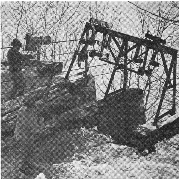
Die Holzseilbahn mit Motorantrieb bringt das Holz unbeschädigt ins Tal.
