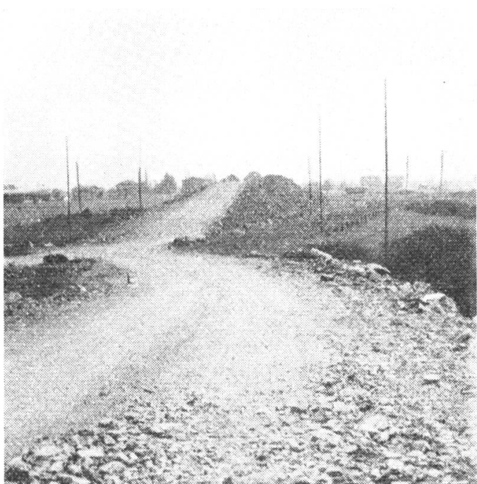
Diese Aufschüttung ist der Beginn des Dammes von 1,5 km Länge. In der Mitte entsteht die Eisenbahnbrücke von 85 m. Sie führt über den Feldweg, Autobahn, Kanal und Rotzlochstraße. Ihre lichte Höhe beträgt 4,5 m.
