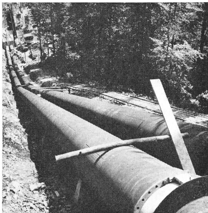
Die Druckleitung zum Kraftwerk Dallenwil 1,45 m Lichtweite, 242 m Länge Foto A. Polster, Stans
