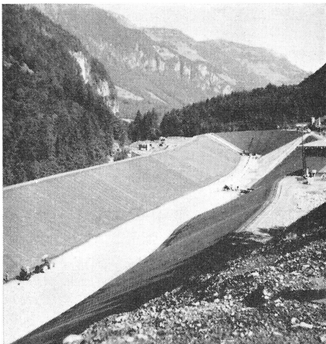
Das Staubecken in Obermatt beim Abschluß der bitumengetränkten Drainageschicht und des Beckenbelages auf den Böschungen und der Sohle
