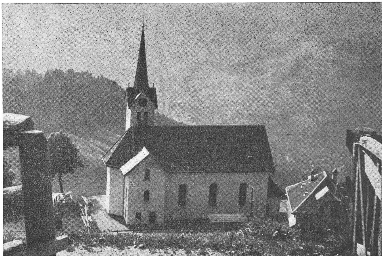
Die Wallfahrtskapelle Niederrickenbach nach der Renovation
