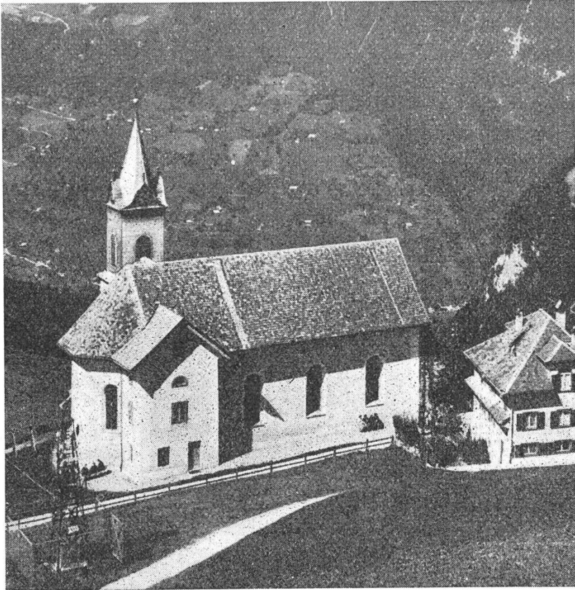
Die Wallfahrtskapelle Niederridenbach vor der Renovation
