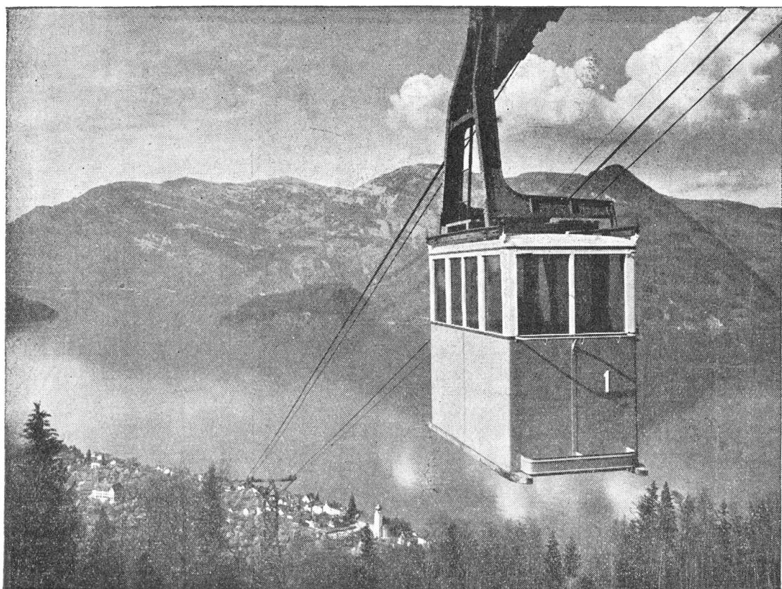
Von acht pyramidenförmigen Eisenmasten werden die Seile getragen, die im Pendelverkehr mit einer Geschwindigkeit von 4 Metern in der Sekunde gleichzeitig Berg- und Talfahrt vermitteln. Dabei wird eine Höhendifferenz von 1146 Metern überwunden. Die Laufbahn ist 3110 Meter lang. Die Tragseile, je aus einem Stück, sind 34 mm dick und vollverschlossen. Es ist gebildet aus 61 Rundkerndrähten und 22 Profilverstärkern. Jedes Seil wiegt über 400 Zentner.
