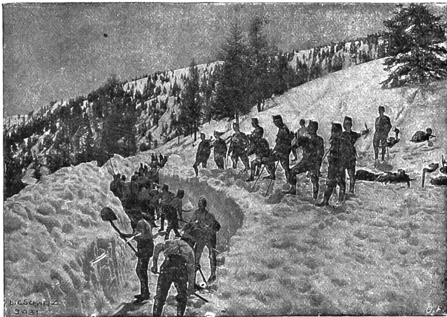
Von der Grenzwacht 1917. — Schneebrucharbeiten im Tessin.
