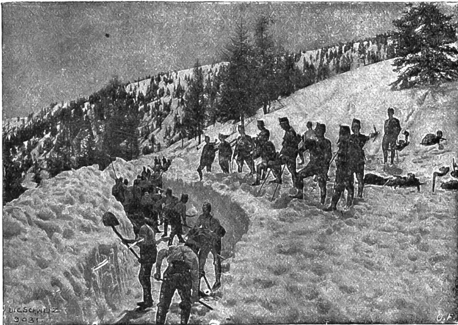
Von der Grenzwehr 1917. — Schneebrucharbeiten im Tessin.
