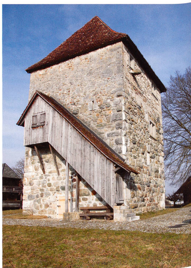
Abb. 1: Burgturm von Halten, von Süden, Mauern bis über den Hocheingang aus der Bauzeit um 1200, oberes Stockwerk von 1543 aus Tuffstein und Bruchsteinen, Dach neuzeitlich
