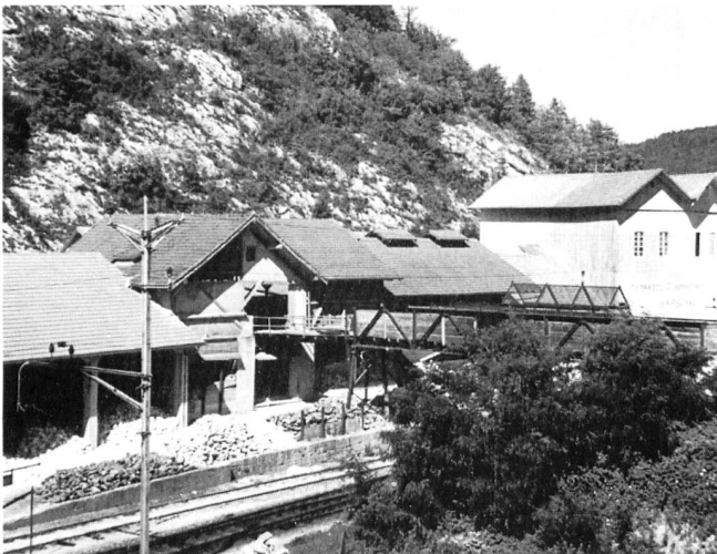
Brücke der Rollbahn über das Bahngeleise um 1950 (Zur Verfügung gestellt von der Carlo Bernasconi AG, Bärschwil)
