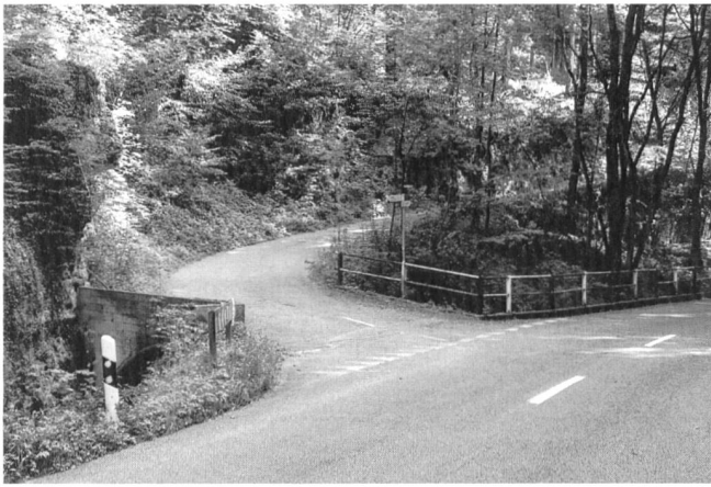
Stürmenbachbrücke (Abzweigung zum Stürmenhof)
