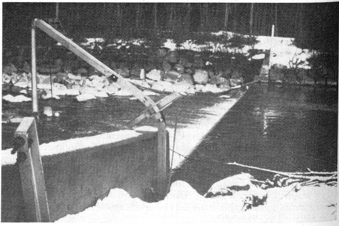
Abb.12: Durch ein Hochwasser im Jahr 1968 beschädigter Träger der Meßseilbahn.
