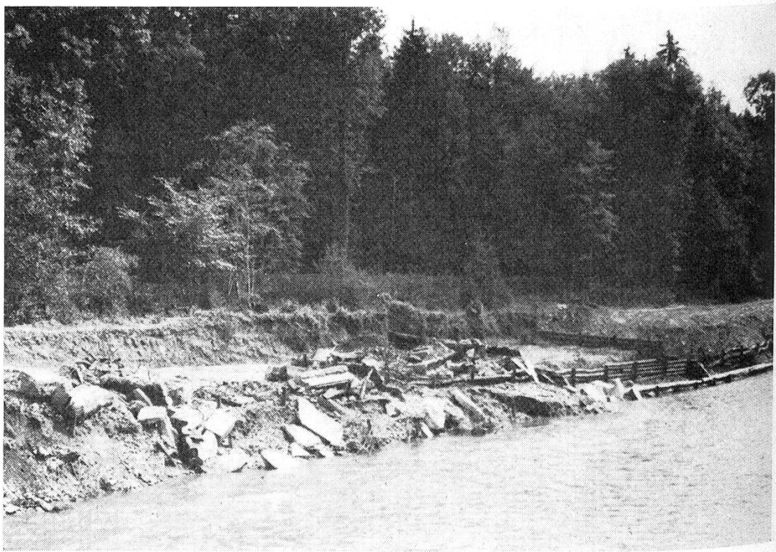
Abb. 26. Uferanriß unmittelbar südl. der Brücke Bätterkinden–Utzenstorf, Sommer 1971.
