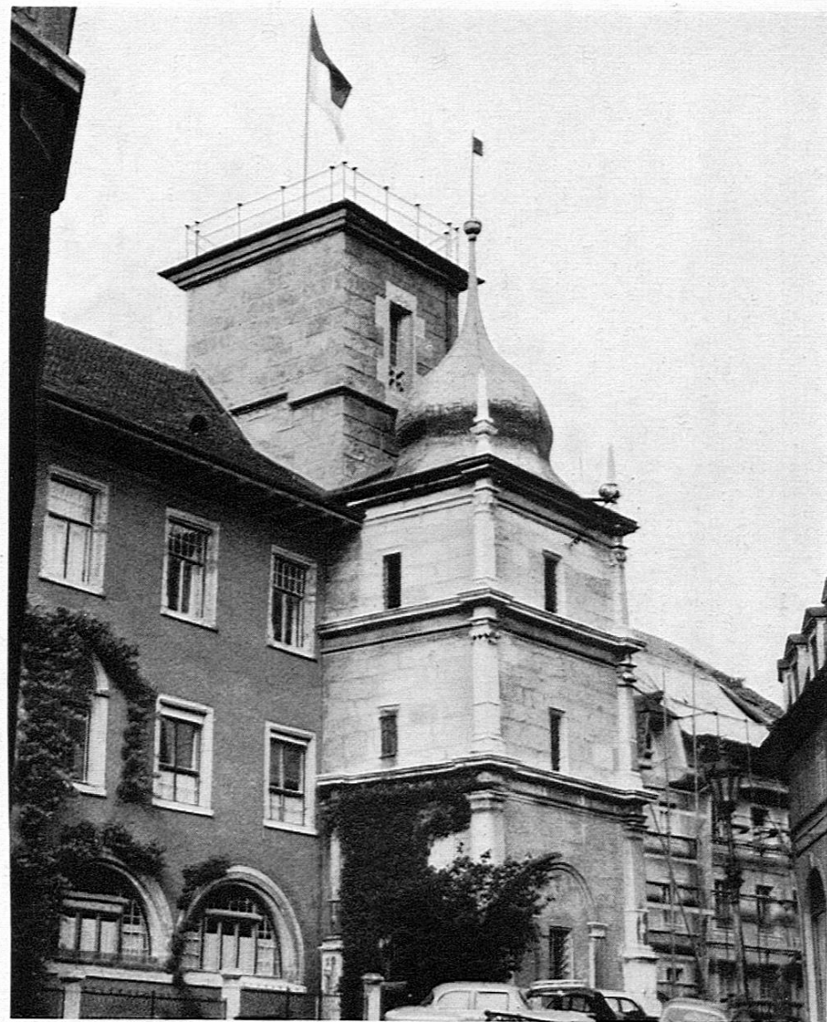
Bild 5 Rathausurm, Einflug unter Dachtraufe des höheren Turmteiles
