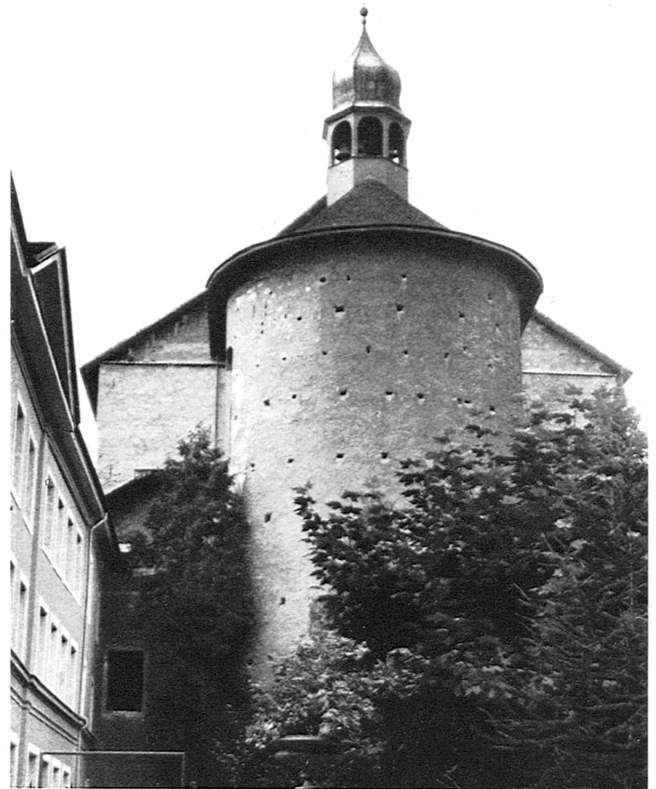
Bild 3 Jesuitenkirche von Süden, Einflug unter Dach
