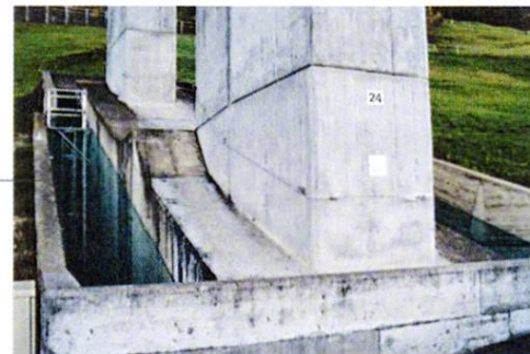
Sicht auf die Doppelpfeiler an der Oberfläche; Schachtumrandung mit Netz als Absturzsicherung
