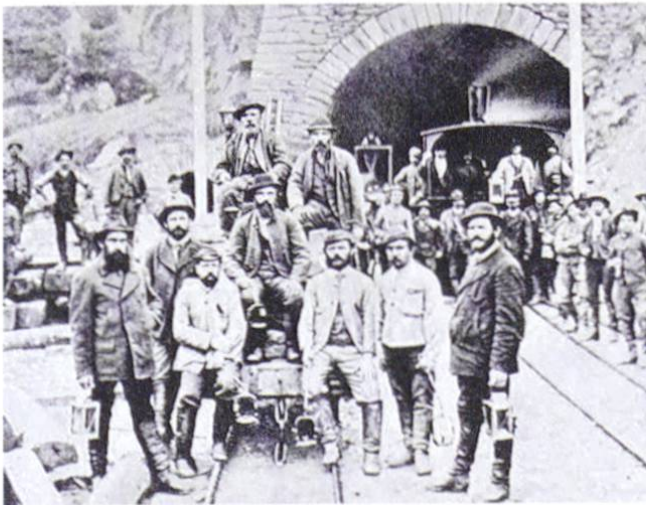
Nicht zuletzt dank des Sprengstoffes aus Isleten fertiggestellt: der erste Gotthard-Bahntunnel bei der Eröffnung 1882
