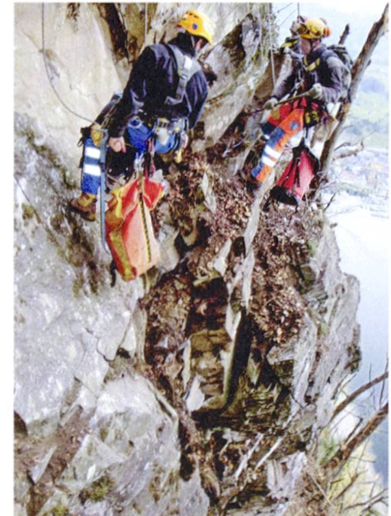
Knochenjob in grosser Höhe zum Schutz der Kantonsstrasse vor Steinschlag: Säuberung der Felsen am Lopper
