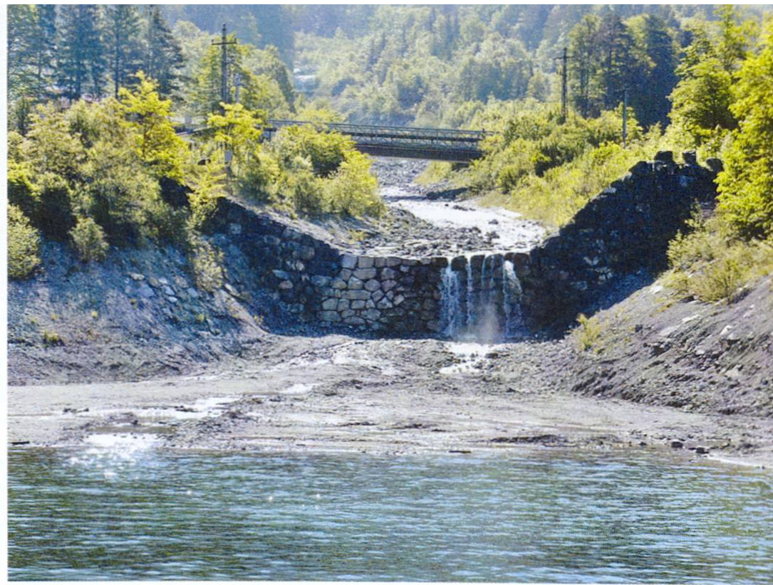
Gotthardbahn-Unterquerung des Gruonbaches mit zwei Tunnelbauwerken
