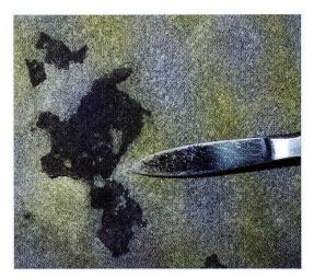
Abb. 6: Durch chemische Verwitterung bzw. Auflösung zurückgewitterte Sandsteinoberfläche mit Relikten einer verschmutzten Gipskruste. (Foto: A. Küng, 28. 4. 2006)
