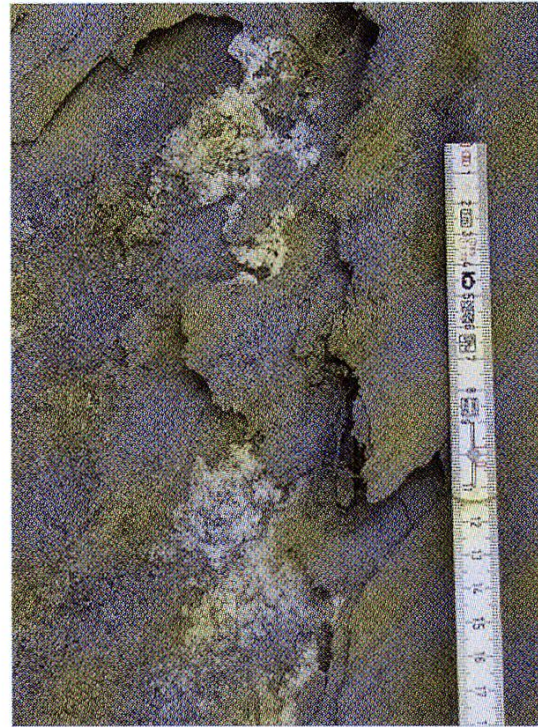
Abb. 3: Die natürlich auftretende und sich wiederholende Kristallisation der wasserlöslichen Sulfatsalze Epsomit ( \text{MgSO}_4 \cdot 7\text{H}_2\text{O} ) und Gips ( \text{CaSO}_4 \cdot 2\text{H}_2\text{O} ) führt zu einer absanden- und abschuppenden Sandstein-oberfläche. (Foto: A. Küng, 2. Mai 2006)
