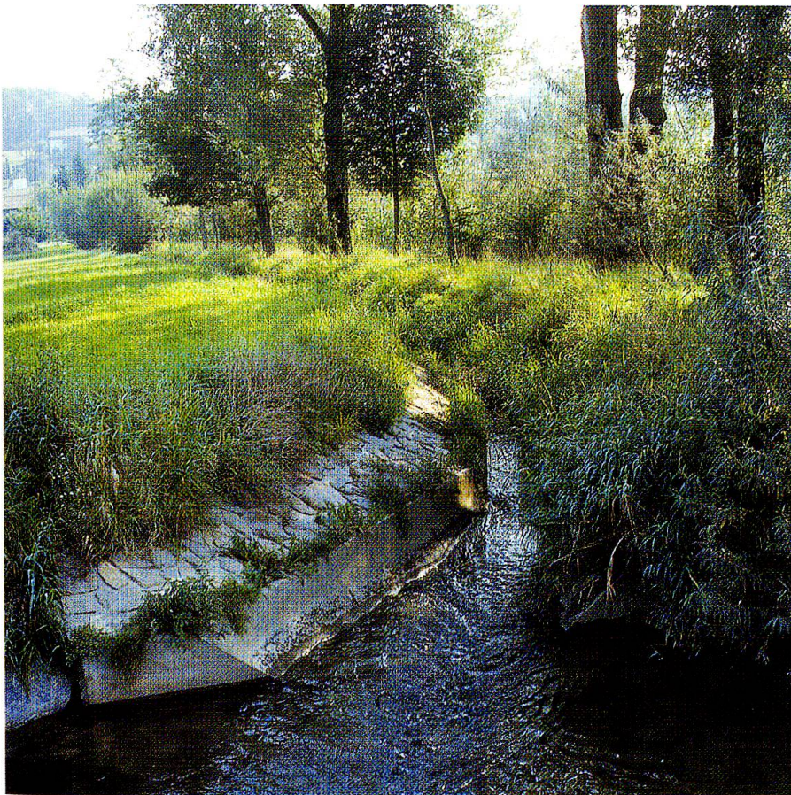
Abb. 4: Einleitungsstelle des gereinigten Abwassers aus der ARA Hochdorf in die Ron.
