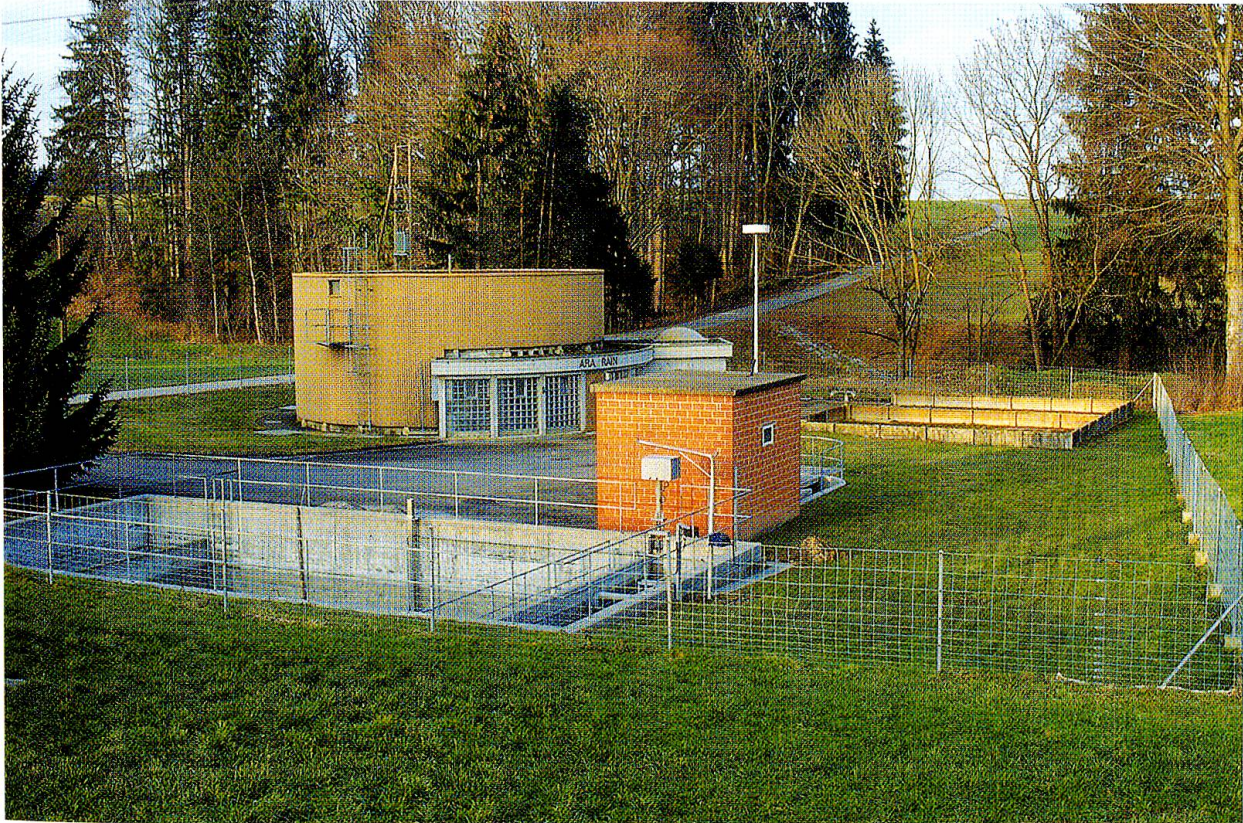
Abb. 1: ARA Rain, aufgehoben im August 2000.
