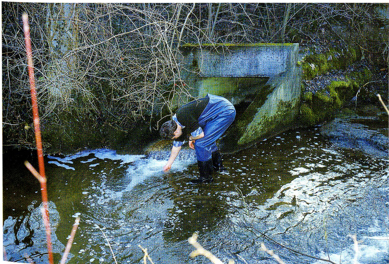
Abb. 2: Einleitung des gereinigten Abwassers aus der ARA Rain in die Ron.
