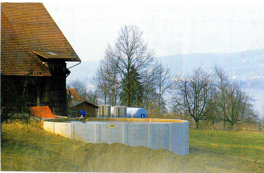
Abb. 16: Bau von Lager- volumen für Gülle, Retschwil 1984.
