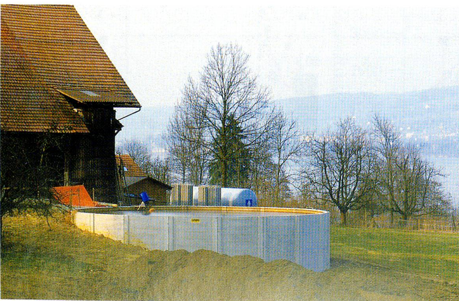
Abb. 16: Bau von Lager- volumen für Gülle, Retschwil 1984.
