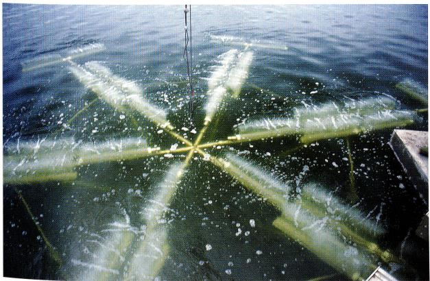
Abb. 20: Diffusor für feinblasige Tiefenwasserbelüftung im Sommer.
