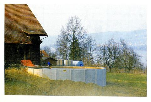
Abb. 16: Bau von Lagervolumen für Gülle, Retschwil 1984.
