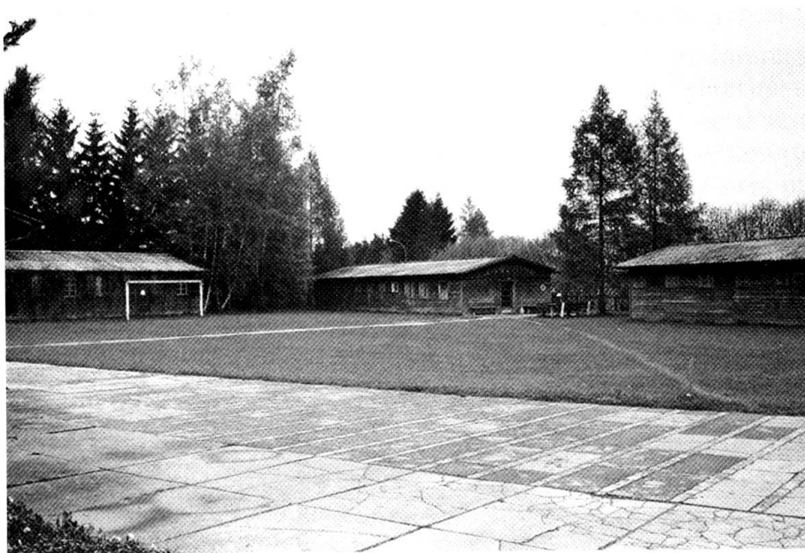
Abb. 1: Alte Anstalt/ Innenhof. Insassen- unterkünfte 1976.
