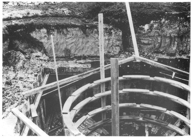
Abb. 9: Der Bau des Senkbrunnens vom Pumpwerk I in der Gützerzusammenlegung Wauwil; deutlich zu sehen ist die mächtige Seekreideschicht unter der dünnen Torfüberdeckung.
