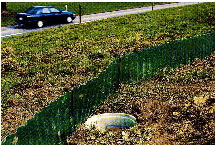
Abb. 1: Amphibienzaun aus Hartplastik (ab 1990) mit Fangkessel. Foto C. Zinkernagel, Hagimoos, 1993.
