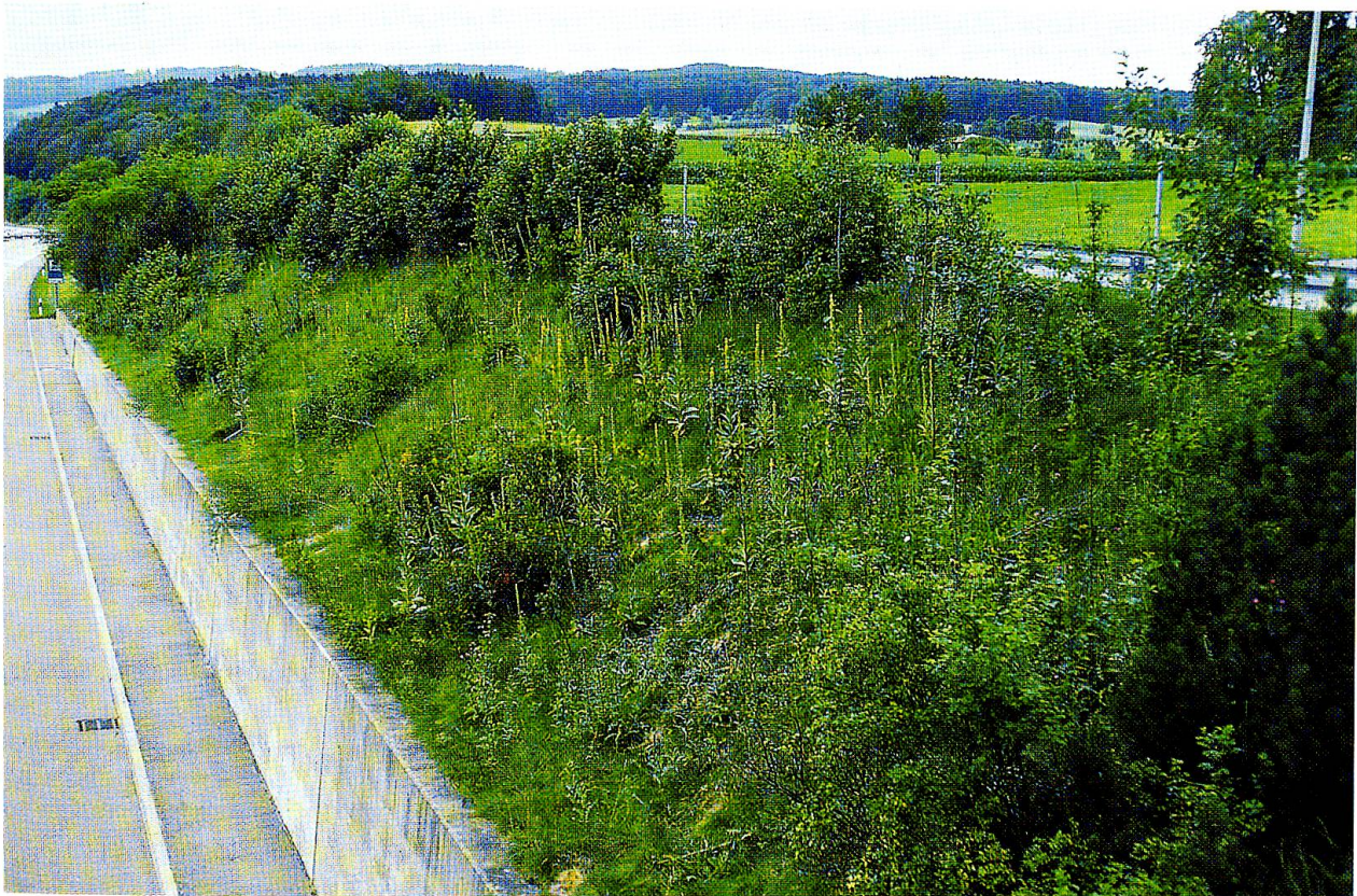
Abb. 1: Wiesenböschungen entlang der Nationalstrassen im Kanton Luzern: Der fehlende Schnitt bewirkt eine lückige Vegetationsdecke und zunehmende Verbuschung.
