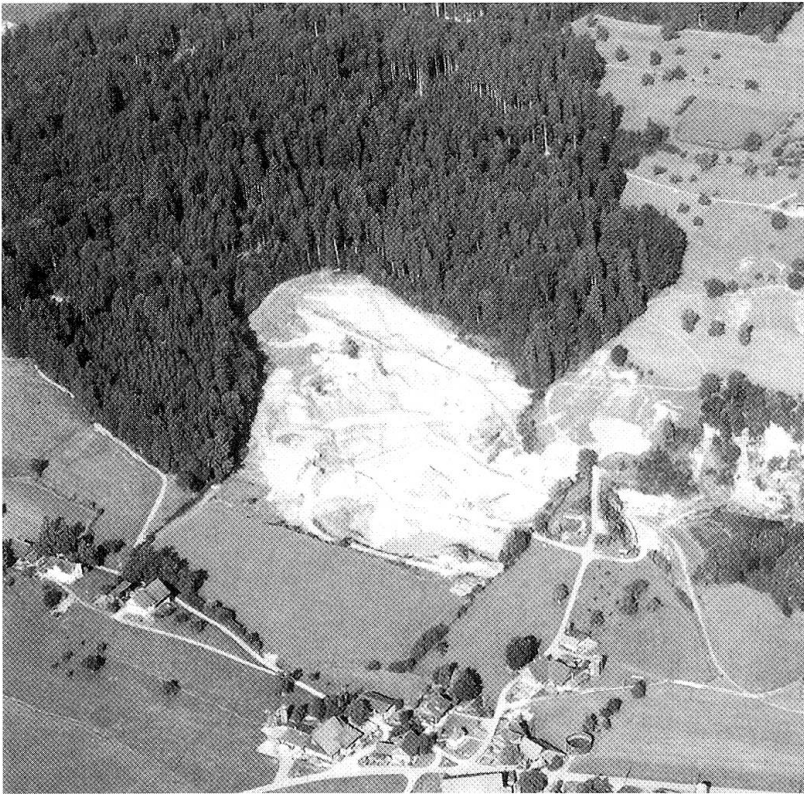
Abb. 7: Rechts die alte Grube z.T. bewaldet, heute wertvoller Amphibienstandort; die aktuelle Grube wird hangseitig in den Wald und in das angrenzende Wiesland erweitert. (Alle Fotos und Grafiken: O. LANG).
